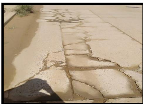
**Figura 1:** Fallas y grietas en el Jr. Sinchi Roca
