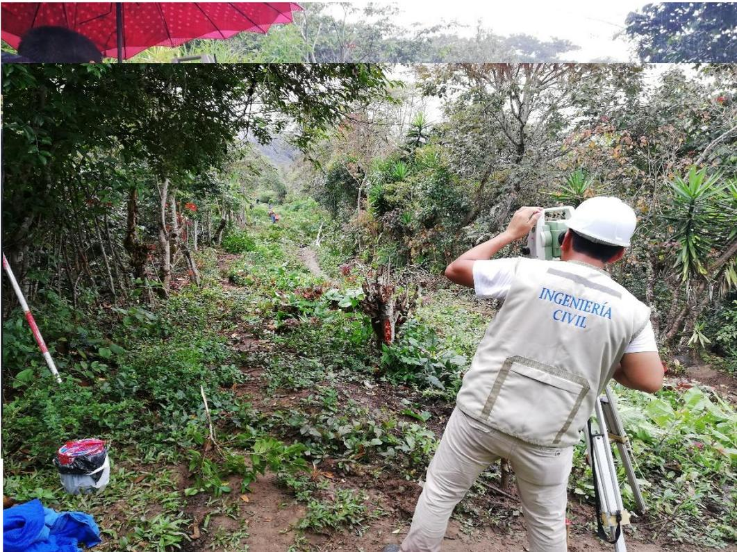
Foto N° 4: Levantamiento topográfico de sección transversal cada 20 m y 10 m
