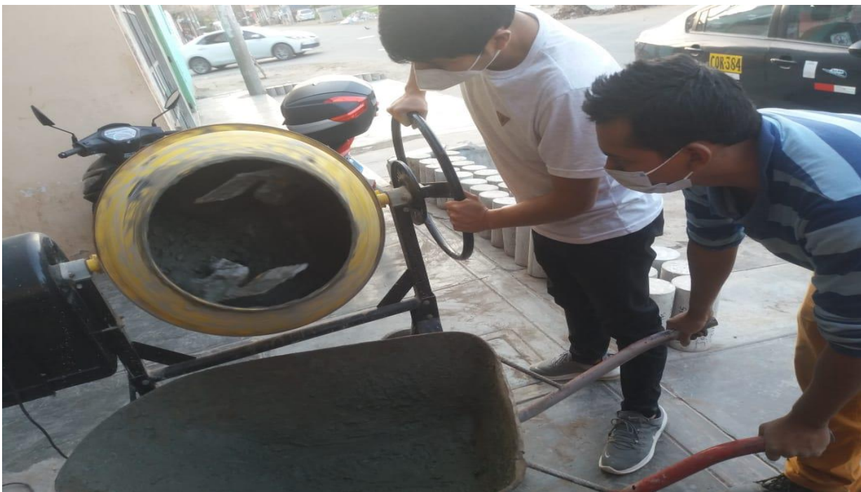
Anexo 10: Realización de la mezcla del concreto con el diseño calculado de un f'c = 210 \text{ kg/cm}^2 .
