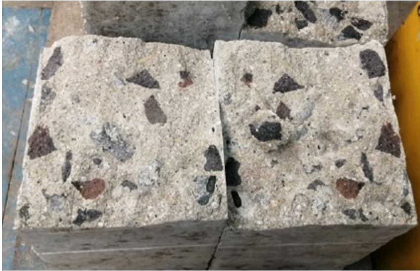
Foto 27. Vista interior de la viga de concreto L35A2.
