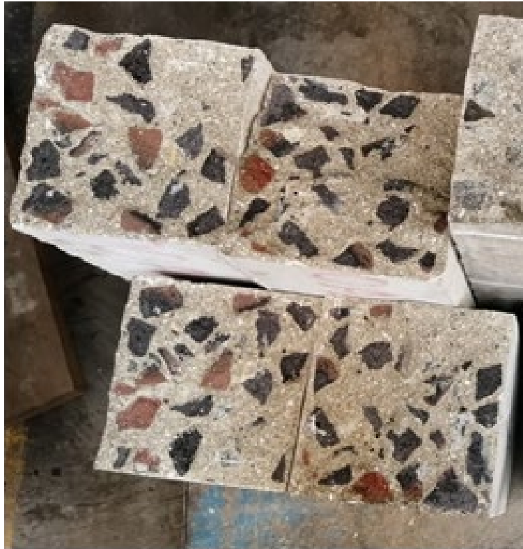
Foto 29. Vista interior de la viga de concreto L100A6.
