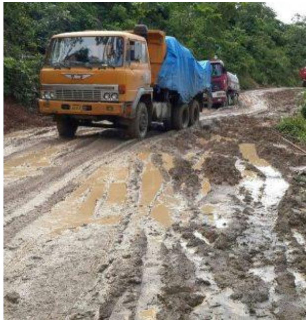
Figura 7. Drenaje inadmisibile.
