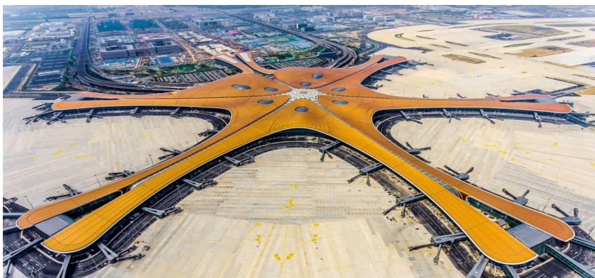
Figura 1. Aeropuerto de Pekín Daxing
