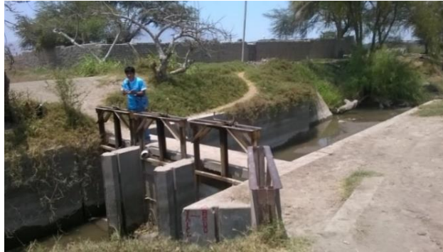
Fotos en la que se aprecia la toma de captación del canal de riego Yalcuchique
