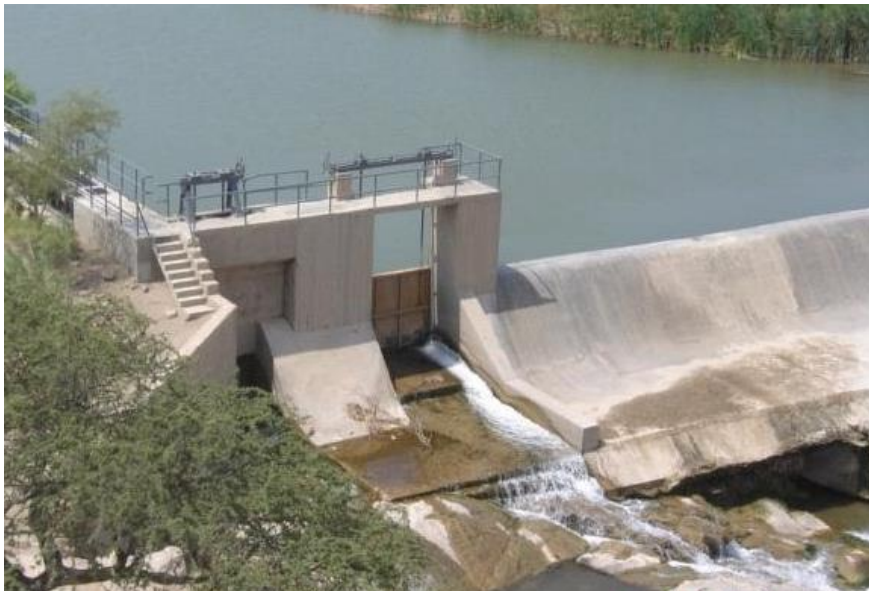
Bocatoma Monsefú, donde se capta el canal Monsefú, a 9 km más adelante esta la captación del canal Yalcuchique
