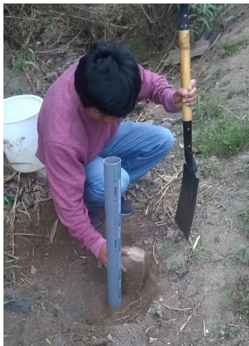
Fotos se aprecia el desarrollo de los estudios de la prueba de Infiltración del canal de riego Yalcuchique.
