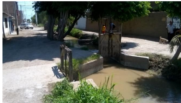
Fotos se aprecia toma lateral y retención del canal de riego Yalcuchique
