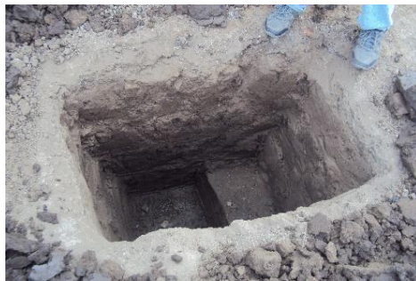
Fotos se aprecia realización de calicatas en el canal de riego Yalcuchique
