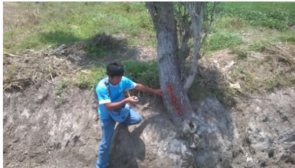
Fotos se aprecia la colocación de kilometraje canal de riego Yalcuchique
