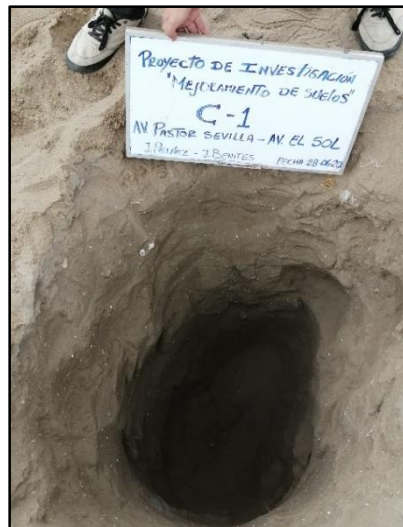
Ilustración 6: foto interna de la calicata
