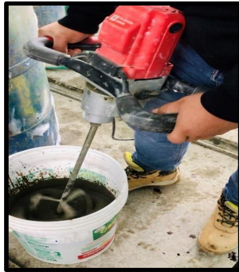
Figura 14. Mezclado de cemento y agua con taladro de alta revolución
