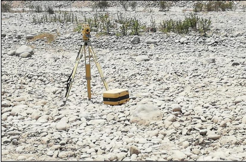
Los equipos de precisión se instalaron en los puntos BM01 y 02 respectivamente cada 50 m para obtener la precisión en cuanto a las elevaciones.
