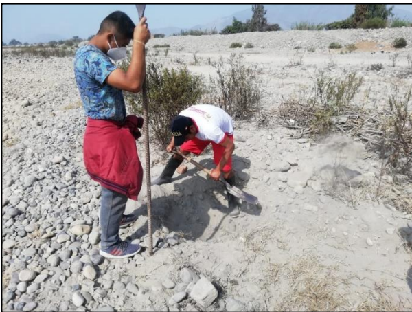
Inicio de los trabajos de excavación
