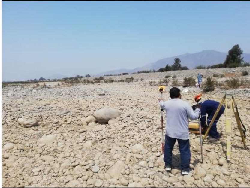
Se realizó los trabajos de topografía; ubicación de puntos BM
