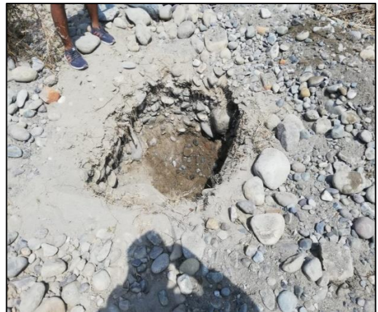
Se visualiza piedras de canto rodado en los estratos de la excavación
