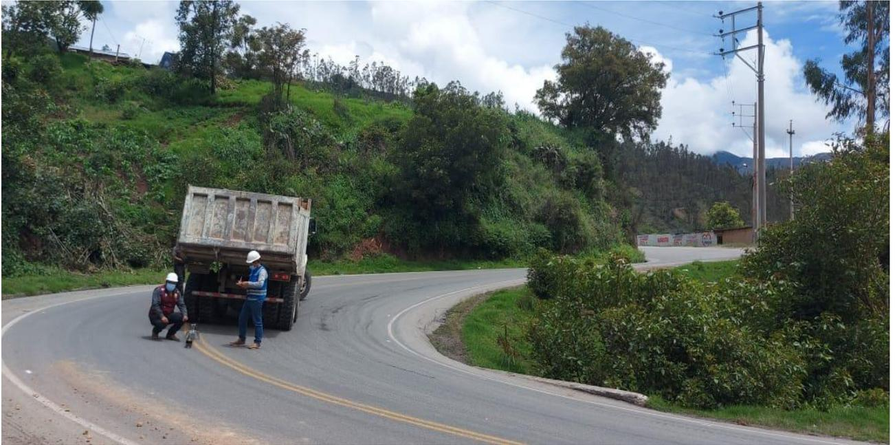
Figura N°07: Toma de lecturas de la viga Benkelman en el eje de la zona de curva n°02
