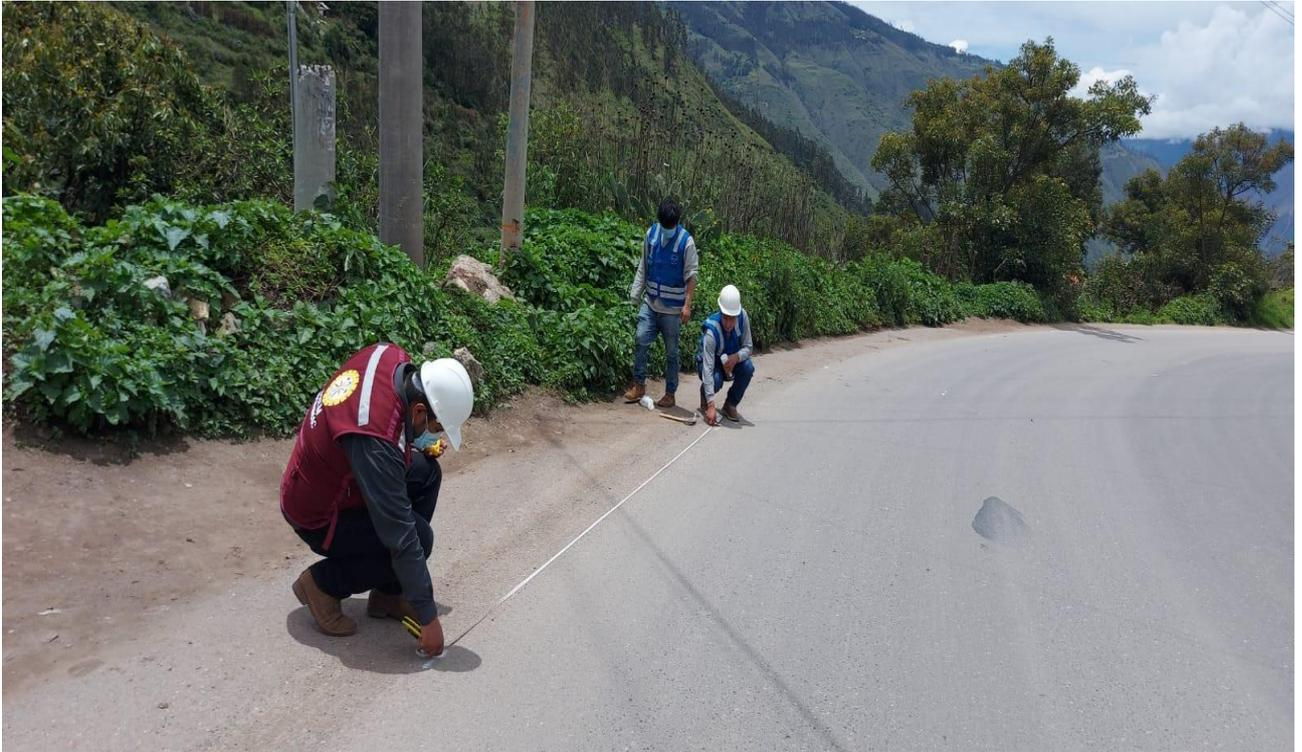
Figura N°10: Ubicación de los puntos a ser evaluados con la viga Benkelman.
