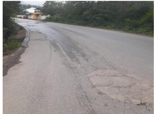
**Figura 2** Fallas en el pavimento
