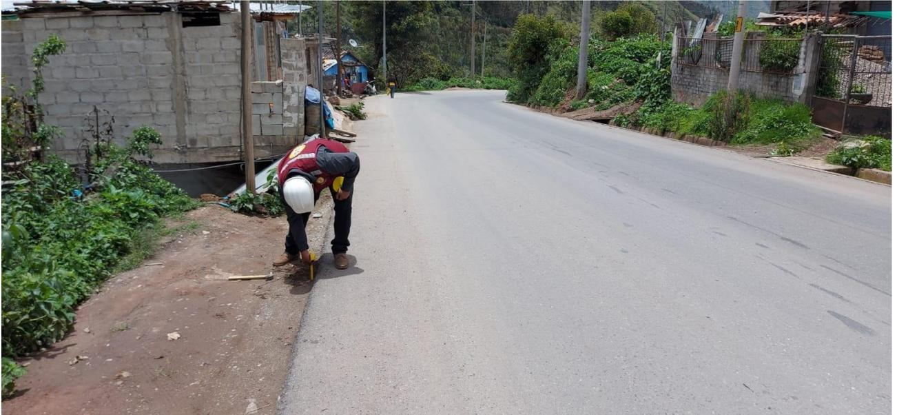
Figura N°09: Medición del espesor del pavimento.
