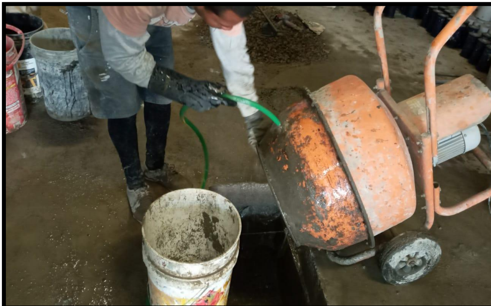
Figura 13. Limpieza de Equipos Mecánicos
