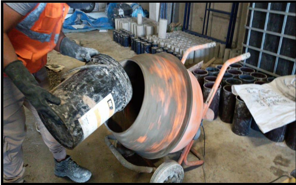
Figura 10. Vertido de Materiales para Dosificación de Concreto F'c 210 kg/cm 2
