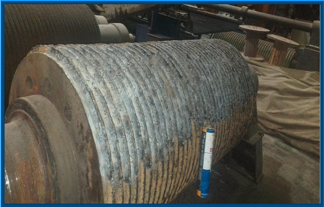
Anexo 18: Durante la recuperación de la maza (aplicación de soldadura eléctrica).
