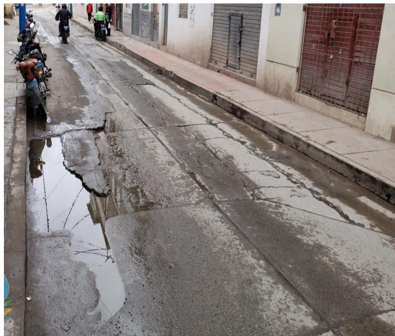
Figura 01. Situación de la Infraestructura vial del Jirón Juan Espinoza Medrano
