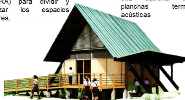
PISO Esta compuesta por vigas y viguetas metálicas, apoyadas sobre zapatas de concreto que sostienen el piso de madera machihembrada.
