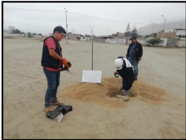
Figura 02: Excavación manual de calicata
