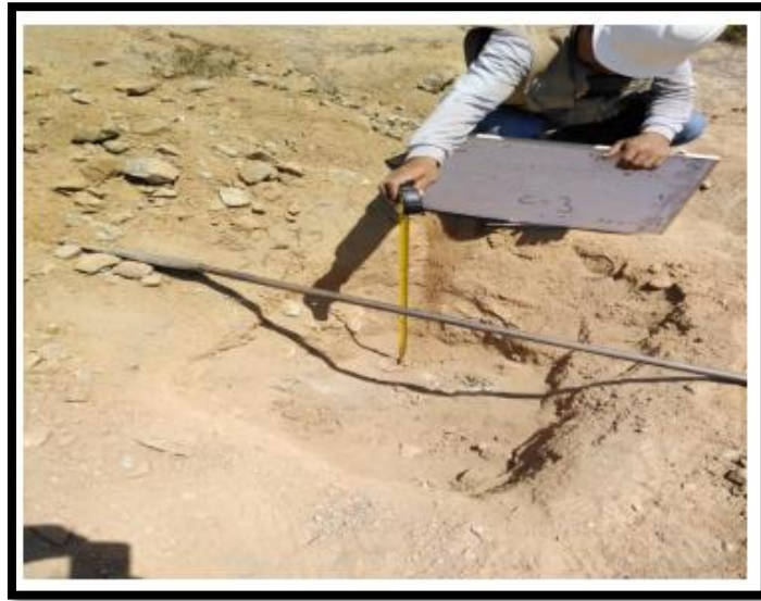
Figura 01: Excavación manual de calicata
