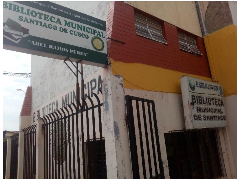
Foto 1: Fachada de la Biblioteca Municipal
