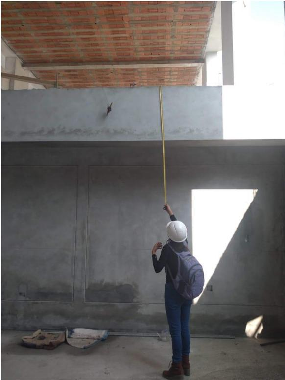
**Foto 3.** Contrastación del peralte en viga de conexión.
