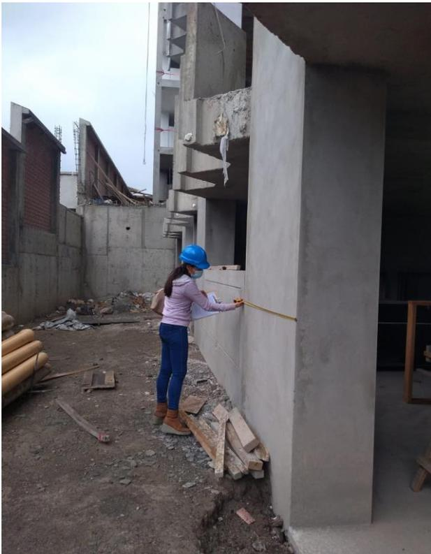
**Foto 2.** Verificación de las secciones en columnas del sótano
