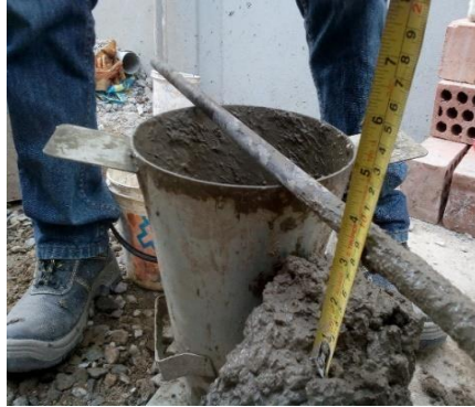
Figura 25. Asentamiento de mezcla patrón para vigas.
