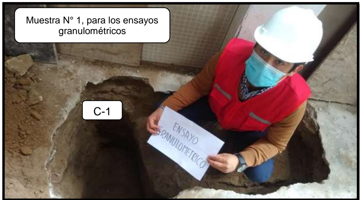
Figura 18: Excavación de calicata N° 1 y la extracción de las muestras.
