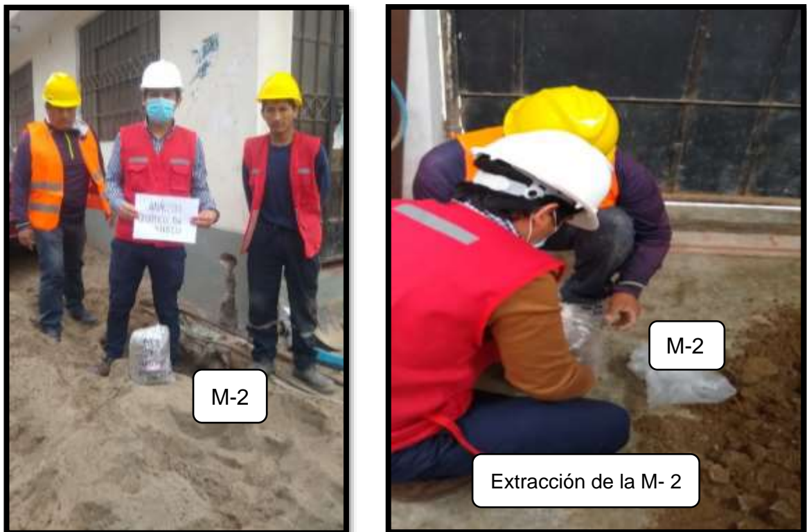
Figura 19: Excavación de Calicata N° 2 y muestras extraídas.
