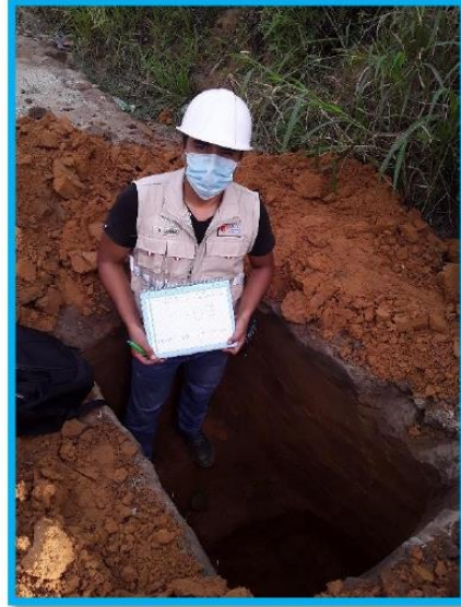
Foto 10: Excavación de la Calicata N° 03 (Coordenadas: 9331848; 283197)
