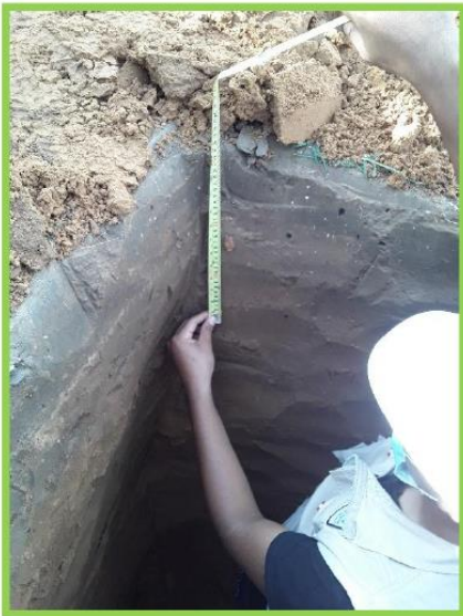
Foto 07: Realizando la estratificación de la Calicata N° 02
