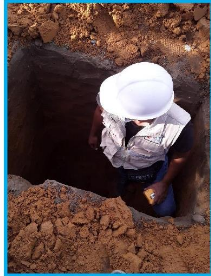
Foto 12: Toma de muestra de la Calicata N° 03
