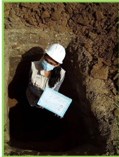
Foto 06: Excavación de la Calicata N° 02 (Coordenadas: 9331797; 283351)
