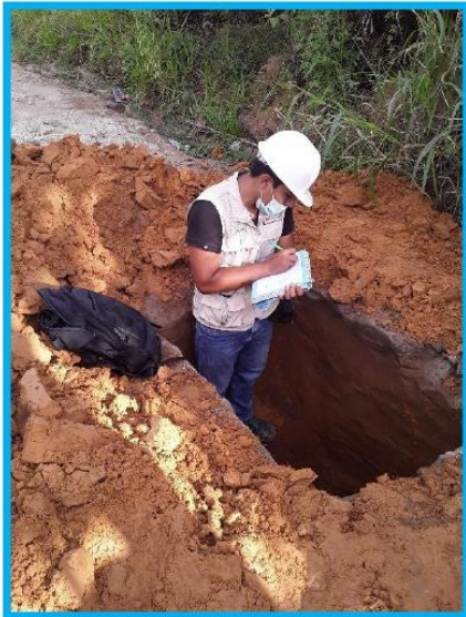
Foto 11: Realizando la estratificación del suelo de la Calicata N° 03
