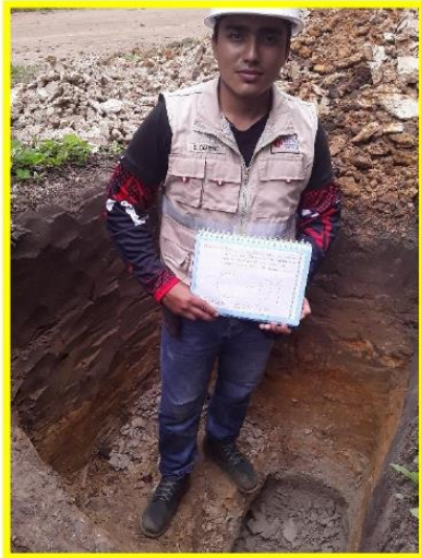
Foto 01: Excavación de la Calicata N° 01 (Coordenadas: 9331779; 283436)
