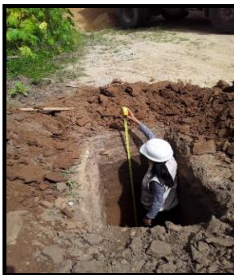
Figura 7. Medición de la profundidad de la calicata, elaboración propia, 2020.
