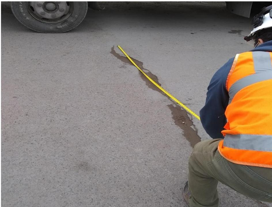
Medición de falla encontrada (Fisura transversal)
