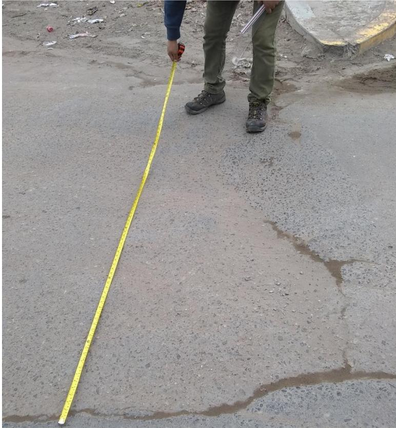
Fallas encontradas (Fisura Transversal y longitudinal)
