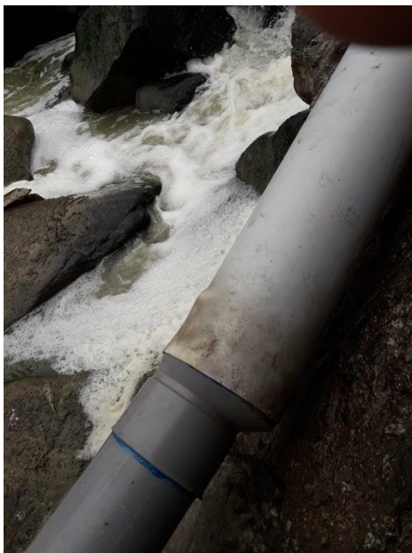
Imagen 3. Fin del primer tramo con tubería de 4" de diámetro, con una reducción de 4" a 3" el resto del recorrido de será con tubería de PVC DE 3" de diámetro hasta la bomba de ariete hidráulico.
