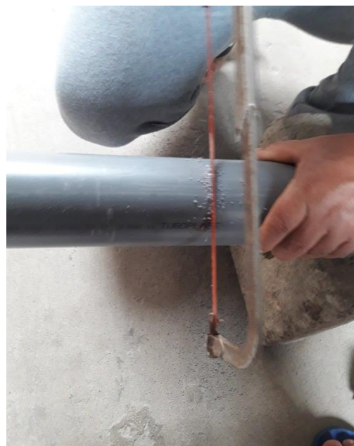
Imagen 4. Niples hechos de PVC de 3" de diámetro.
