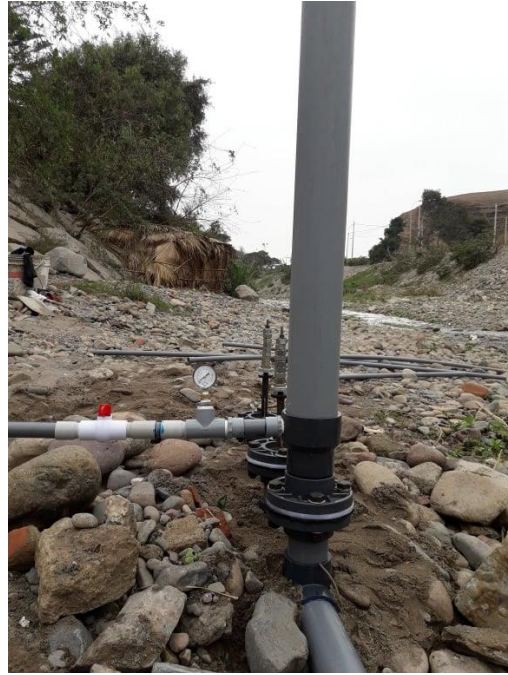
Imagen 4. Armado final de la bomba en el campo, realizando trabajos previos como nivelación de terreno y nivelación de la bomba misma.
