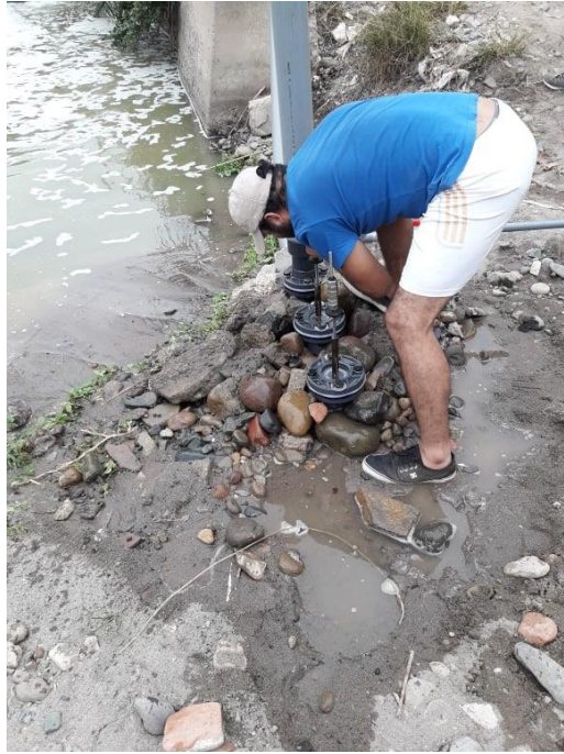
Imagen 4. Armado final de la bomba en el campo, realizando trabajos previos como nivelación de terreno y nivelación de la bomba misma.
