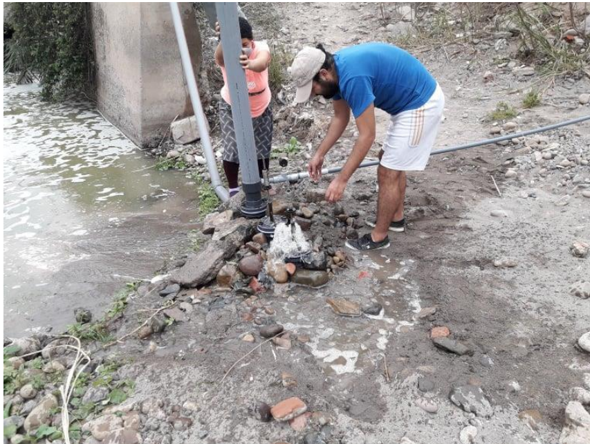
Imagen 1. Puesta en marcha de la bomba de ariete, presionando las válvulas de golpe.
