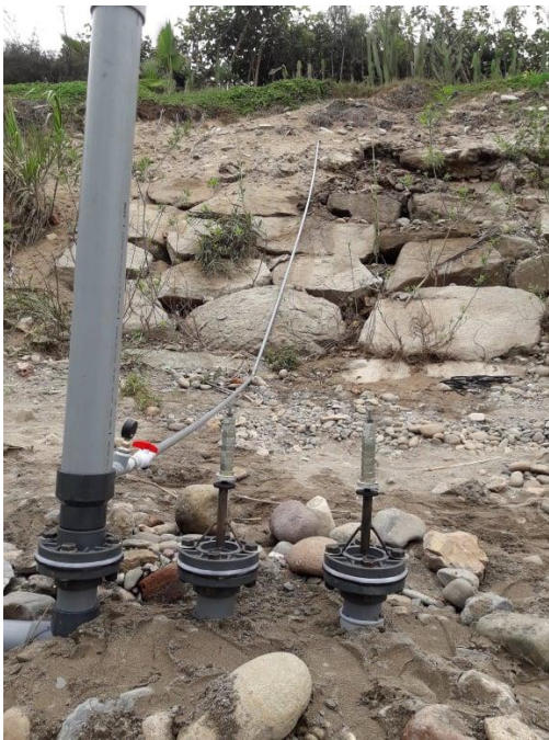
Imagen 1. Conducción de la tubería de descarga, consta de 1" de diámetro y 18 metros de longitud.
