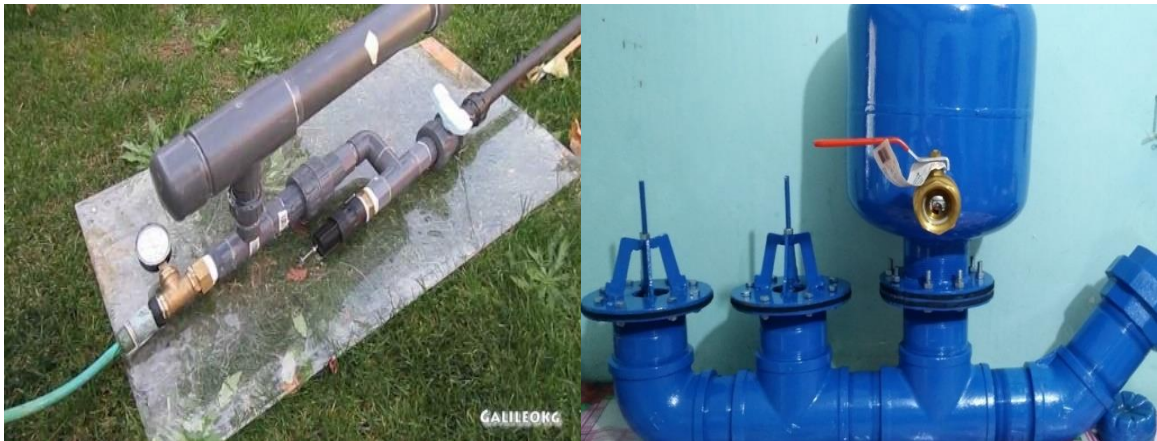
Figura 14: Cámaras de aire PVC y metal, utilizados según la magnitud del proyecto.
