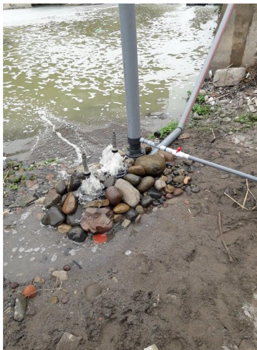
Imagen 2. Funcionamiento de la bomba de ariete con partes de material reciclado.
