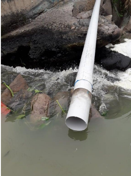
Imagen 2. Tubería PVC de 4" de diámetro colocada en el pozo de captación para encausamiento de agua hacia la bomba de ariete hidráulico.
