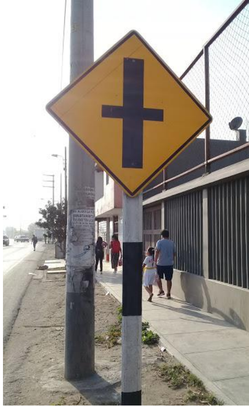
Figura 22: Señal preventiva en la Vía Evitamiento que indica intersección en ángulo recto con Vía Secundaria.
