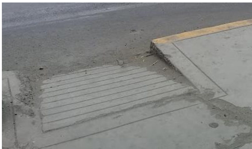
Figura 35: Rampa al costado de la Av. Larco.
