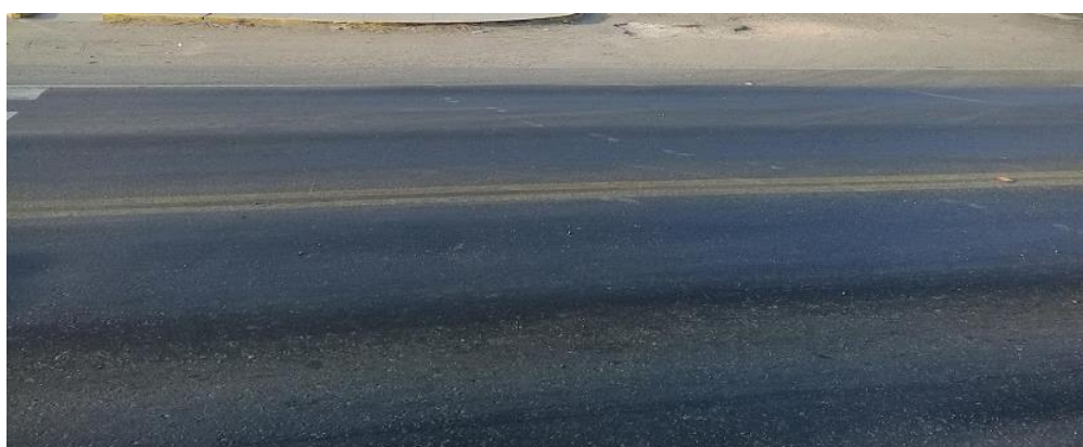
Figura 30: Señalización en la Vía Evitamiento que indica doble sentido de circulación
