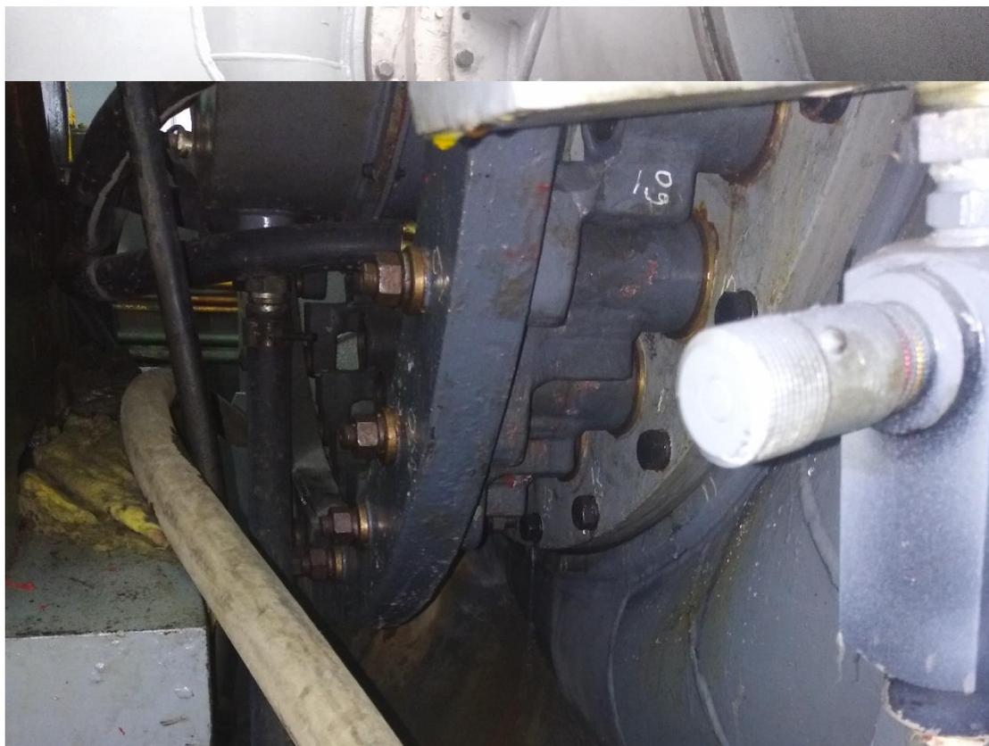
**ANEXO 13. FOTO 8-9. DESMONTAJE Y CALIBRACIÓN DE LOS ALABES DIRECTRICES**
