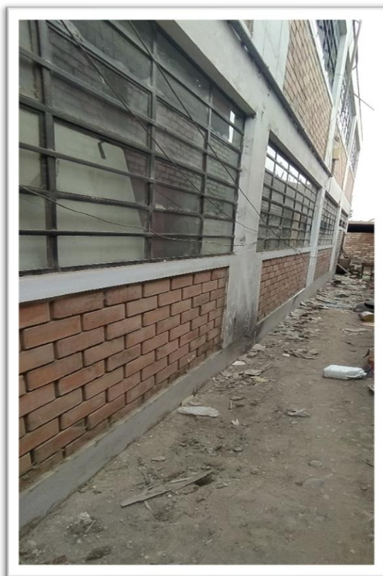
Figura 54. Unidades de mampostería del pabellón 11.
