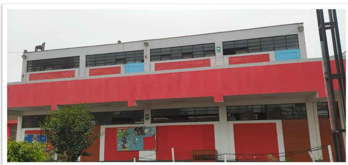
Figura 26. Pabellón 11 – bloque A.
