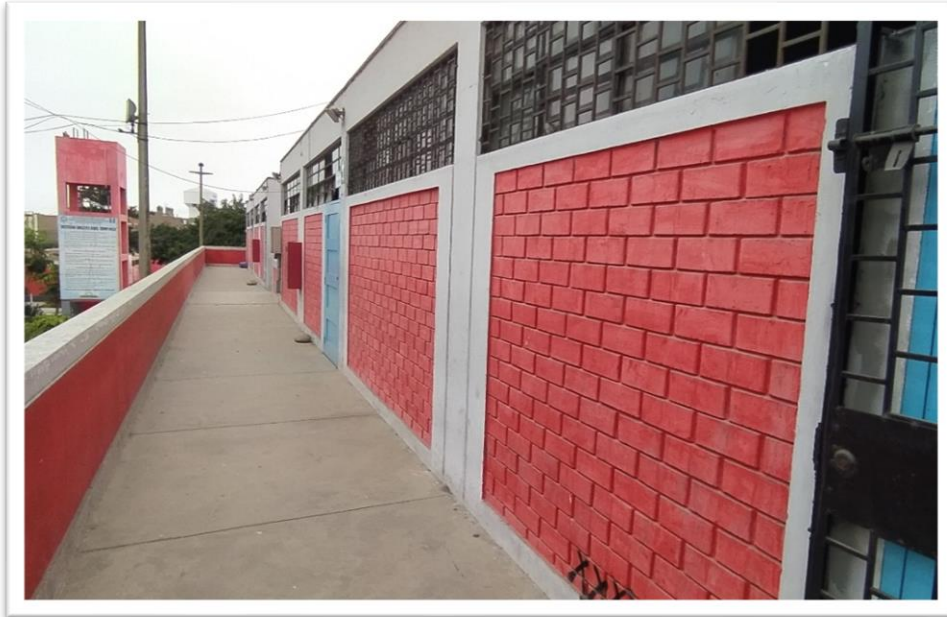
Figura 55. Estructura del segundo nivel del pabellón 11 – bloques A y B.
