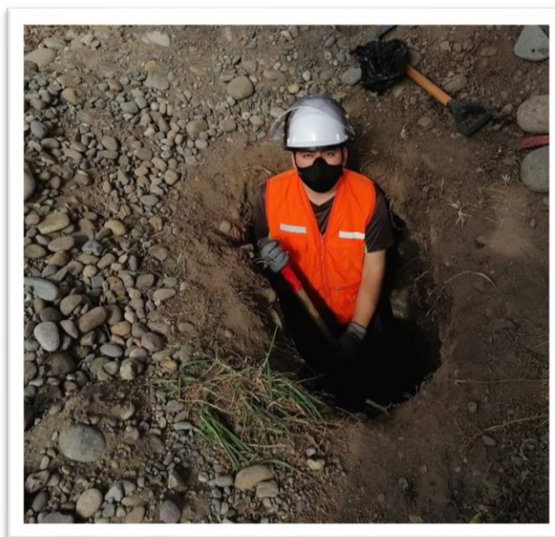
Figura 29. Excavación de Calicata en la I. E. Isabel Chimpu Oclo.
