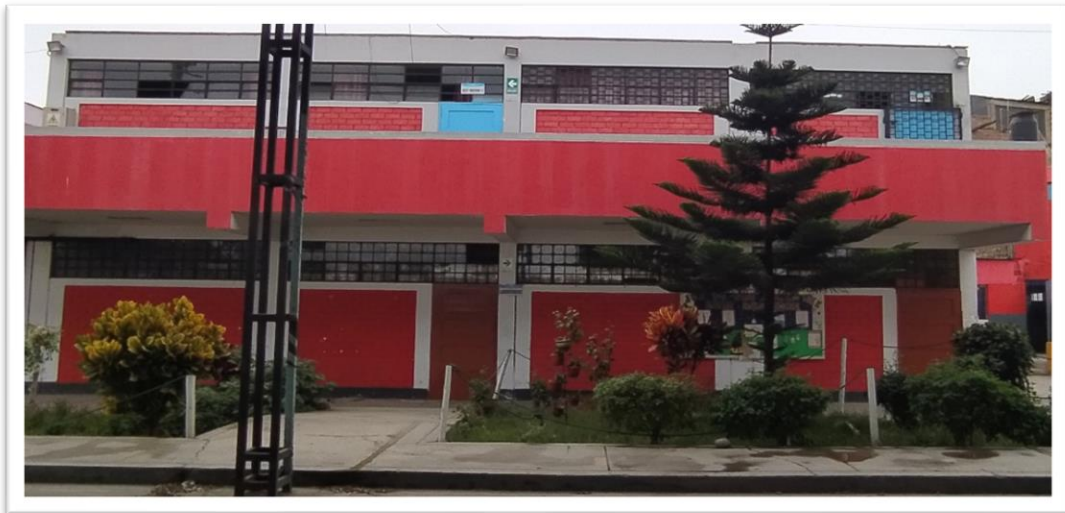
Figura 51. Pabellón 11 - bloque A.
