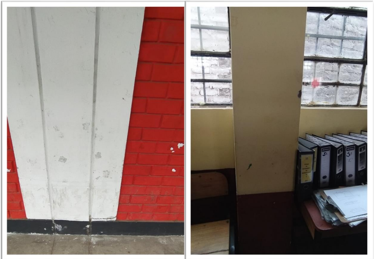
Figura 57. Detalles de columnas y vigas de confinamiento del pabellón 11 – bloque A y B.
