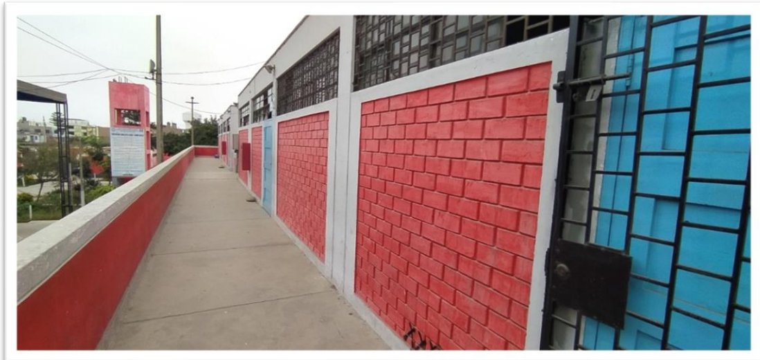
Figura 33. Segundo nivel del pabellón 11 – bloque A.
