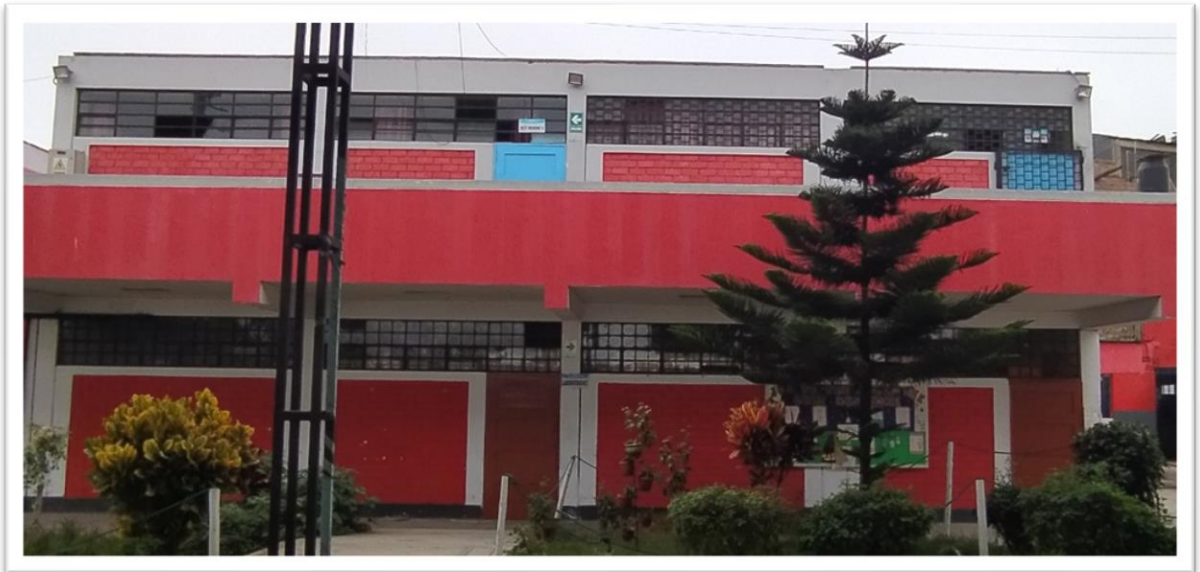
Figura 40. Pabellón 11 – bloque A.
