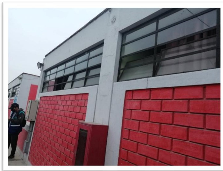
Figura 44. Losa Aligerada (Diafragma Rígido) en el segundo piso del pabellón 11 – bloques A y B.
