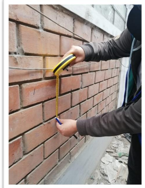
Figura 21. Muros de albañilería de la parte posterior del pabellón 11 – bloque B.
