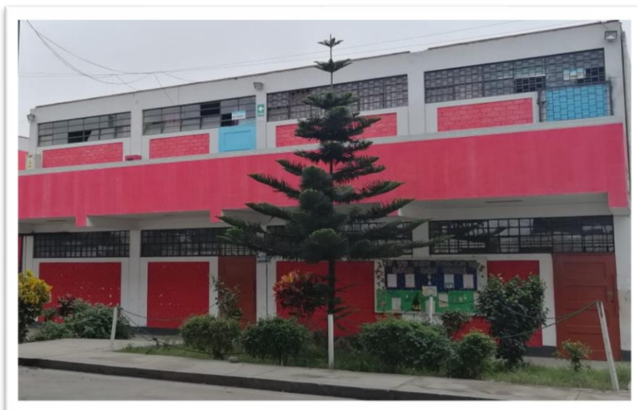
Figura 23. Pabellón 11 – Bloque A.
