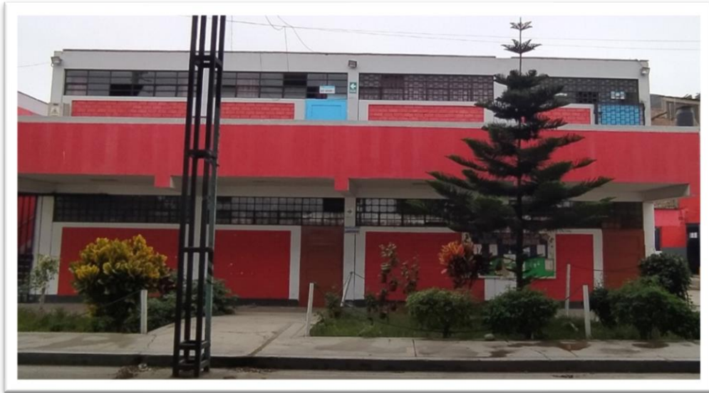
Figura 30. Pabellón 11 – bloque A.
