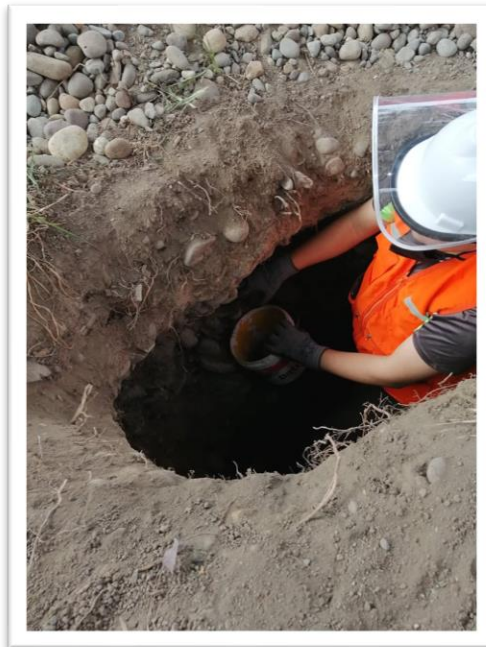
Figura 65. Excavación y extracción de sustratos de la calicata en la institución educativa.
