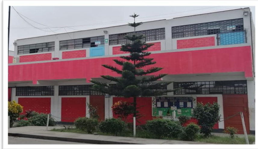
Figura 19. Pabellón 11 – Bloque A.
