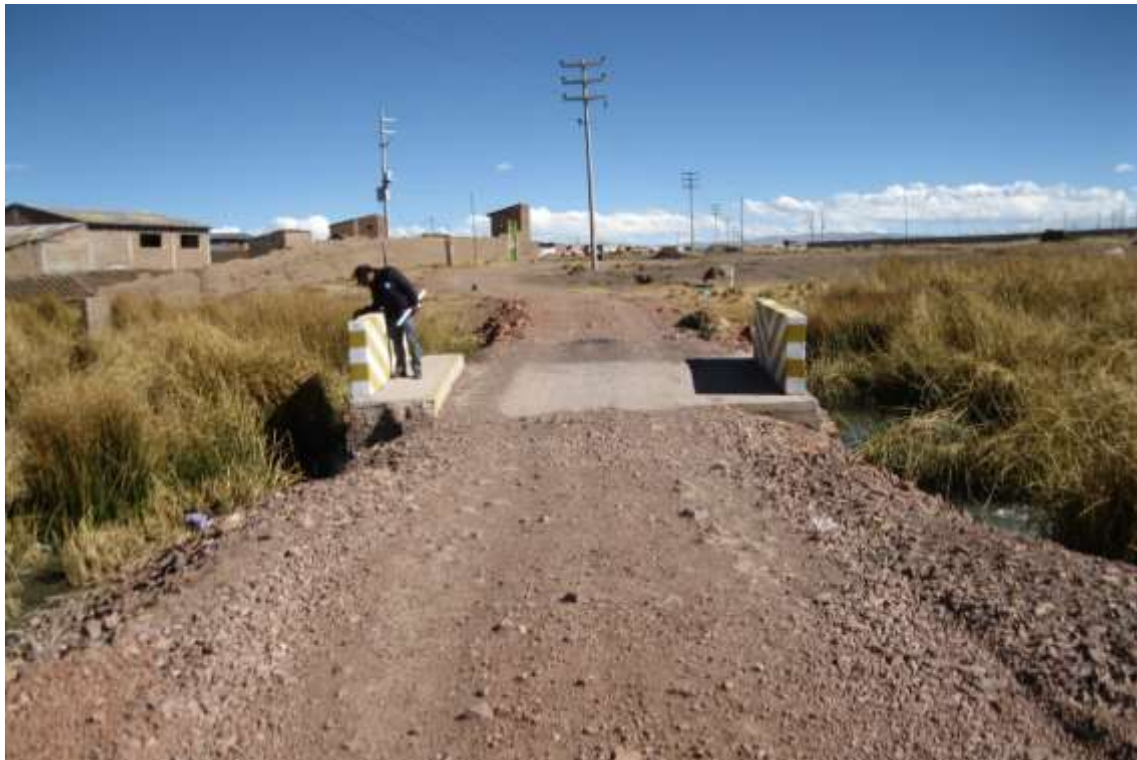
Figura 2 Punto de interés, se aprecia relleno y estrechamiento en el cauce por el pontón.
