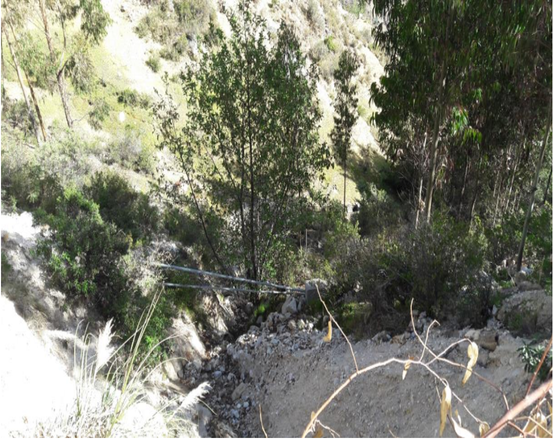
Pase aéreo en Línea de Conducción.
