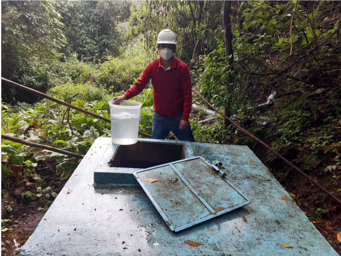
Aforo en la Captación existente.
