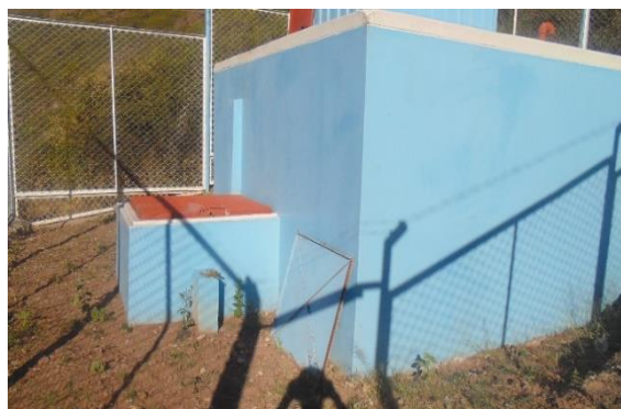
Figura1.2: Reservorio en óptimas condiciones
