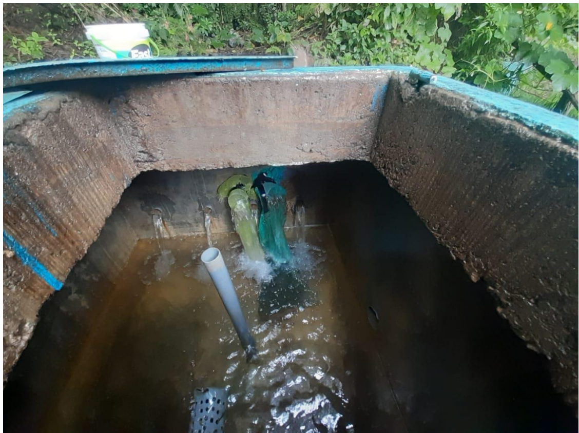
Aforo en la Captación existente.
