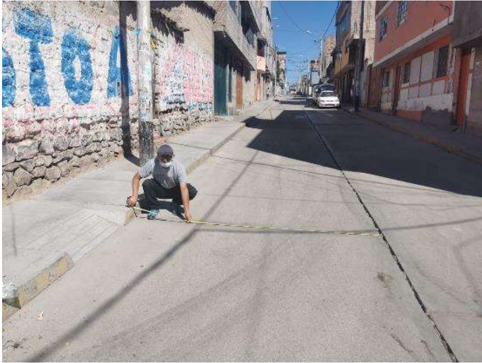
FOTOGRAFIA 09: Pulimiento y Sello de junta cuadra 07 Jr. Porras Barnechea
