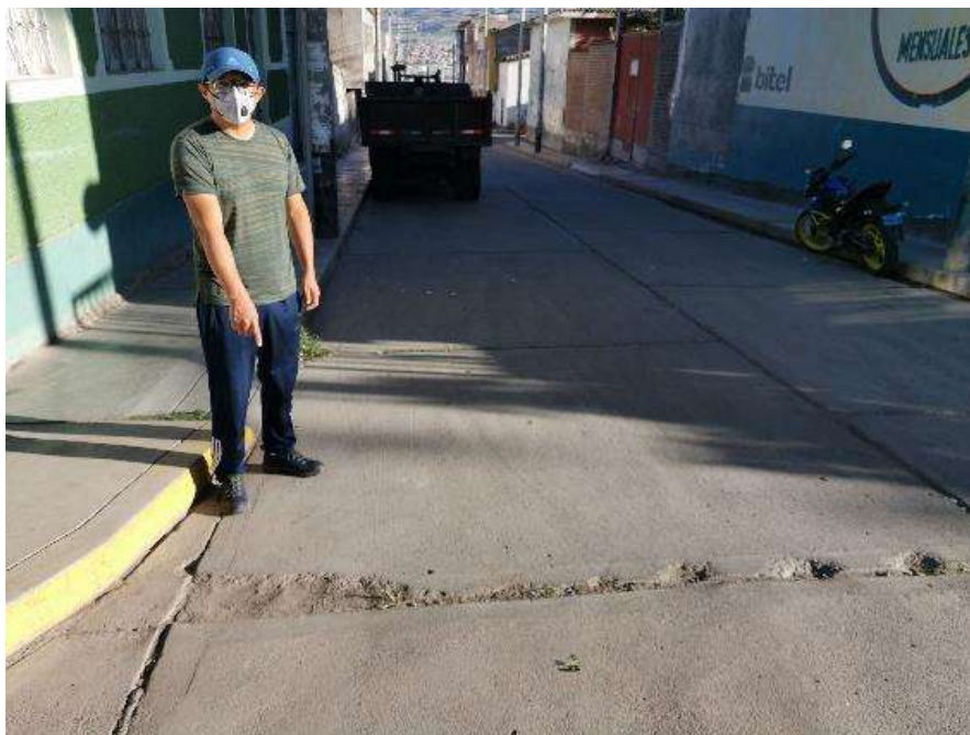
FOTOGRAFIA 08: Escala, Pulimiento Y Sello de junta cuadra 01 Jr. Porras Barnechea
