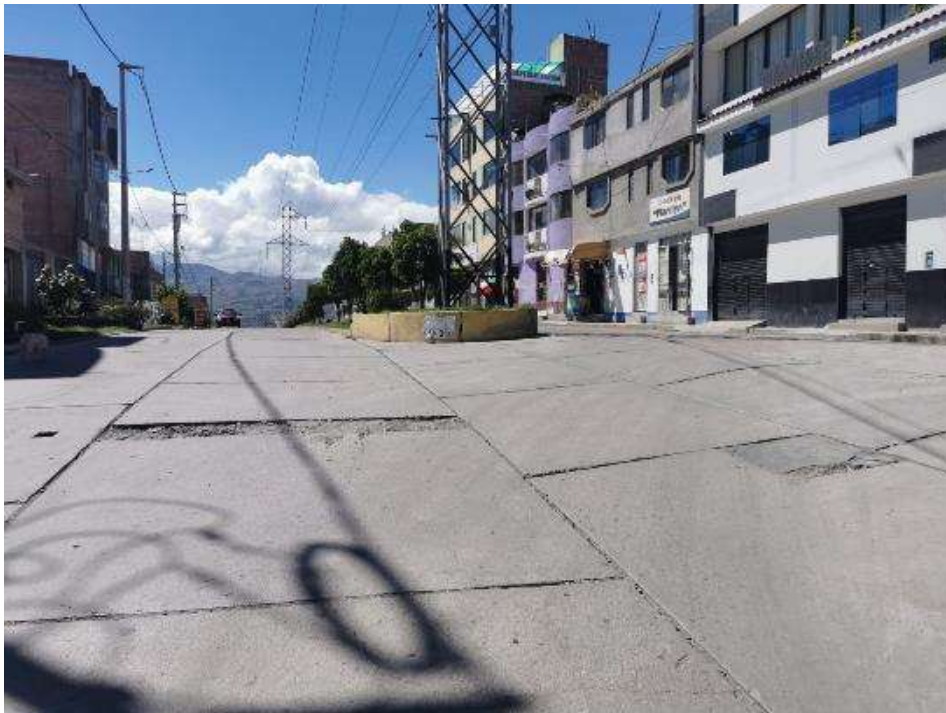
FOTOGRAFIA 04: Parcheo pequeño, pulimiento y sello de junta cuadra 01 Av. San Felipe (norte – sur)
