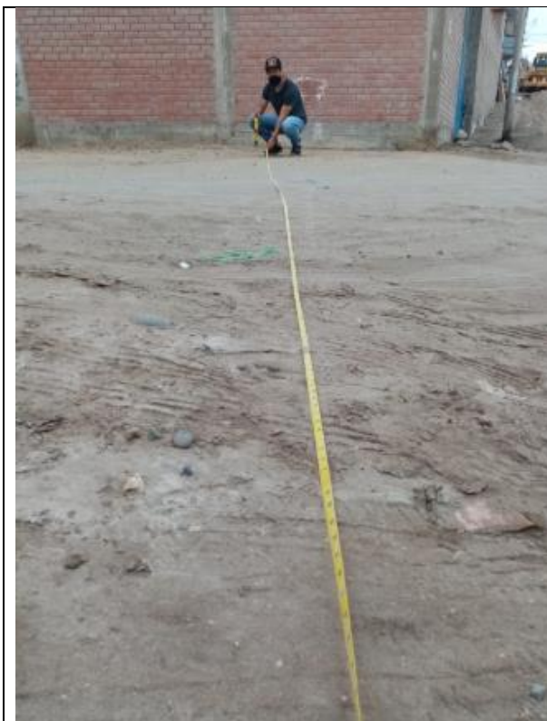
Figura 15 Metrados en campo 1
