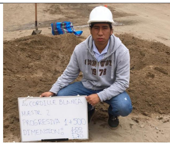
Figura 8 Excavación de calicatas 2
