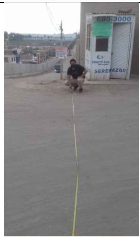
Figura 16 Metrados en campo 2
