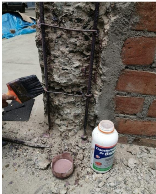
Figura 53. Aplicando el transformador de óxido al acero.
