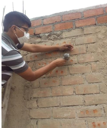
Figura 60. Punto fijo para la empotrar la alcayata
