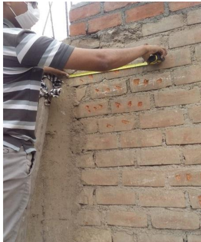
Figura 59. Colocación de alcayata de manera Horizontal.
