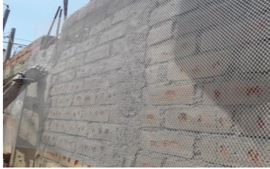
Figura 66. Fijación de la malla desplegada al Muro
