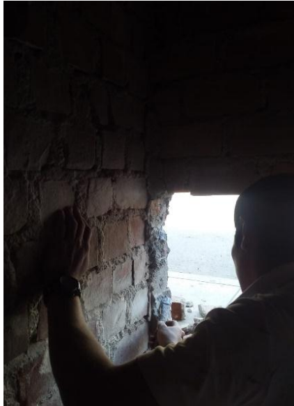
Figura 45. Colocación de la mezcla Sikadur
