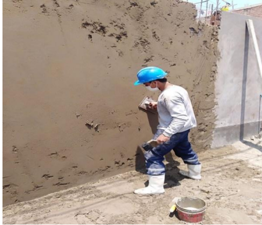
Figura 74. Vivienda Adquiriendo una superficie lisa
