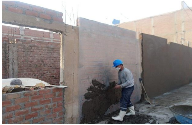
Figura 71. Pañeteo en el muro de albañilería
