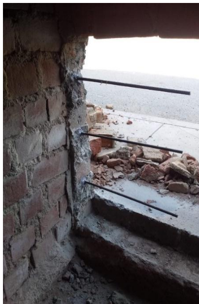
Figura 46. Varilla de acero empotrado
