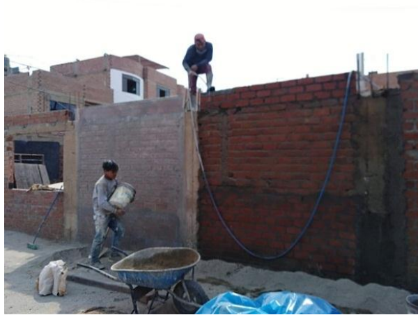
Figura 69. Humedecer el muro de albañilería
