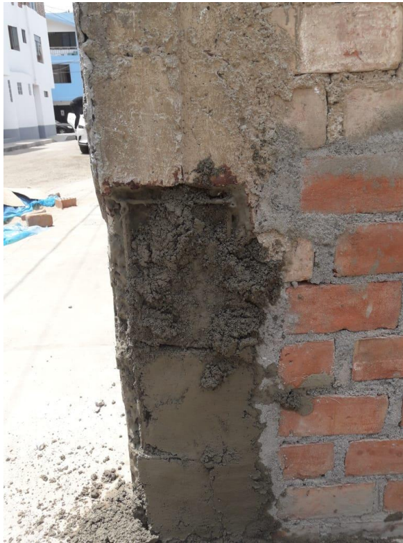
Figura 54. Colocación de mortero en la parte alterada
