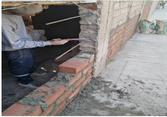
Figura 47. Amarre entre acero y muro
