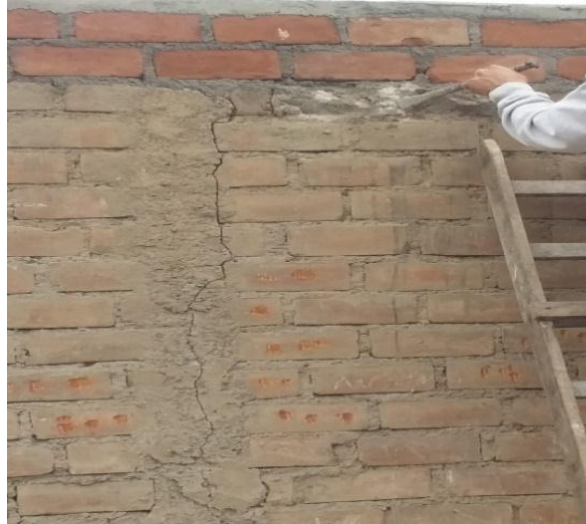
Figura 56. Se procede a picar el muro
