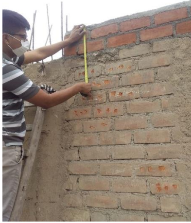
Figura 58. Colocación de alcayata de manera vertical
