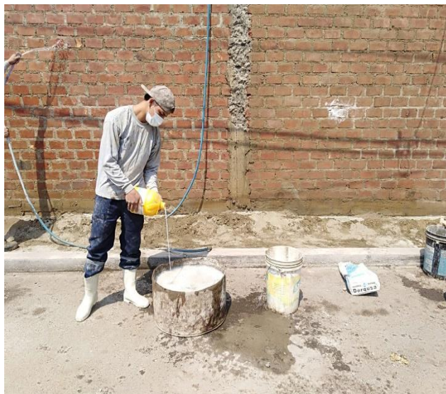
Figura 70. Adición del Aditivo impermeabilizante de mortero
