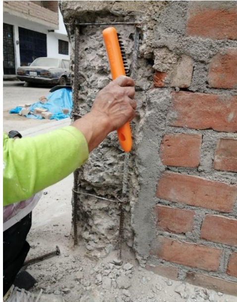
Figura 52. El acero en proceso de limpieza
