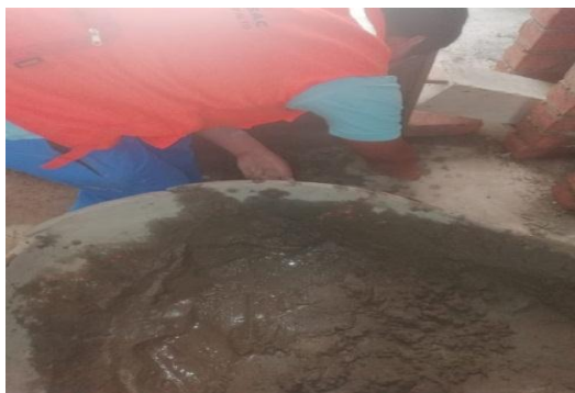
Figura 23. Preparación de mortero
