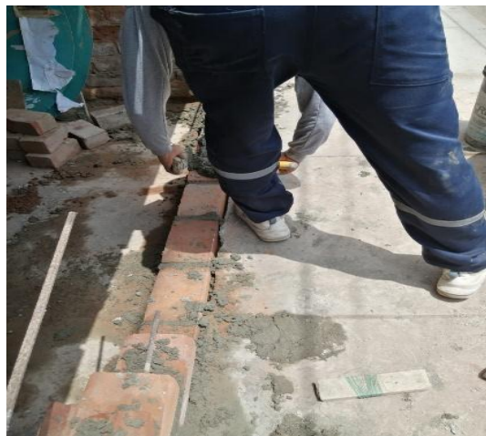
Figura 48. Levantamiento de ladrillo
