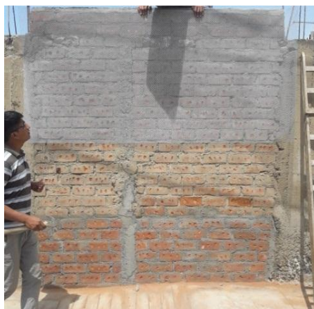
Figura 65. Colocación de la malla desplegada
