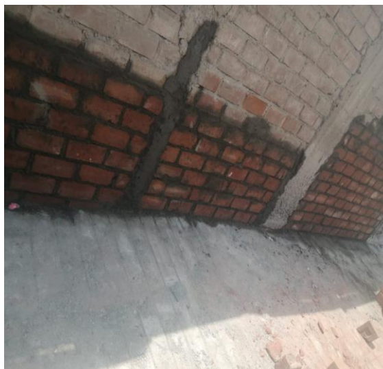
Figura 49. Termino de asentado de ladrillo
