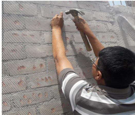
Figura 67. Clavado de las Alcayata
