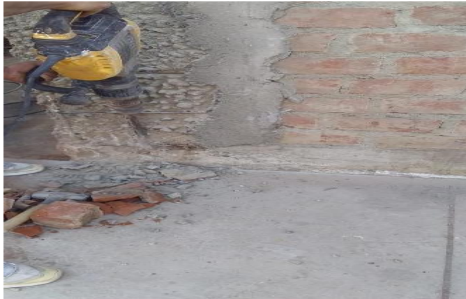
Figura 50. Utilización de martillo picador
