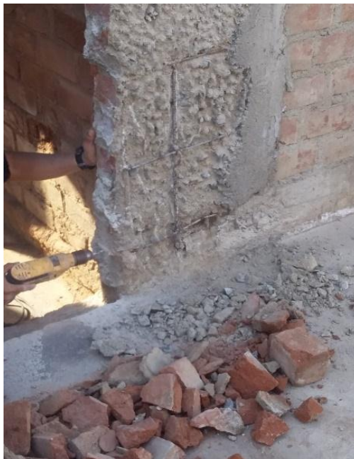
Figura 42. Perforación para colocar el acero
