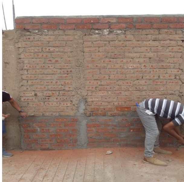
Figura 57. Picar la pared para una mejor adherencia y cohesión
