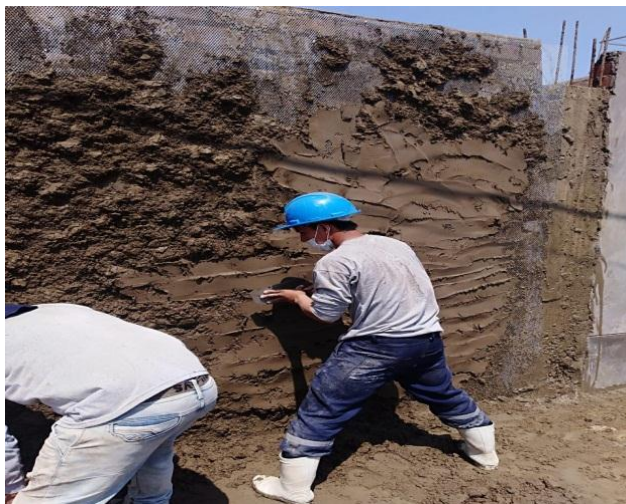
Figura 73. Tarrajeo en el muro de albañilería
