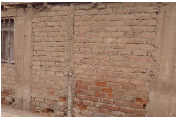
Figura 55. Muro que se reforzara
