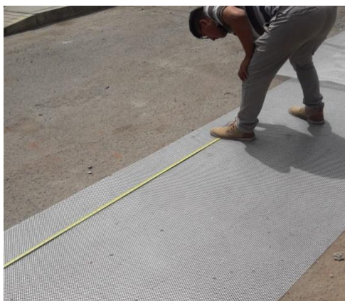
Figura 63. Medición de la malla desplegada
