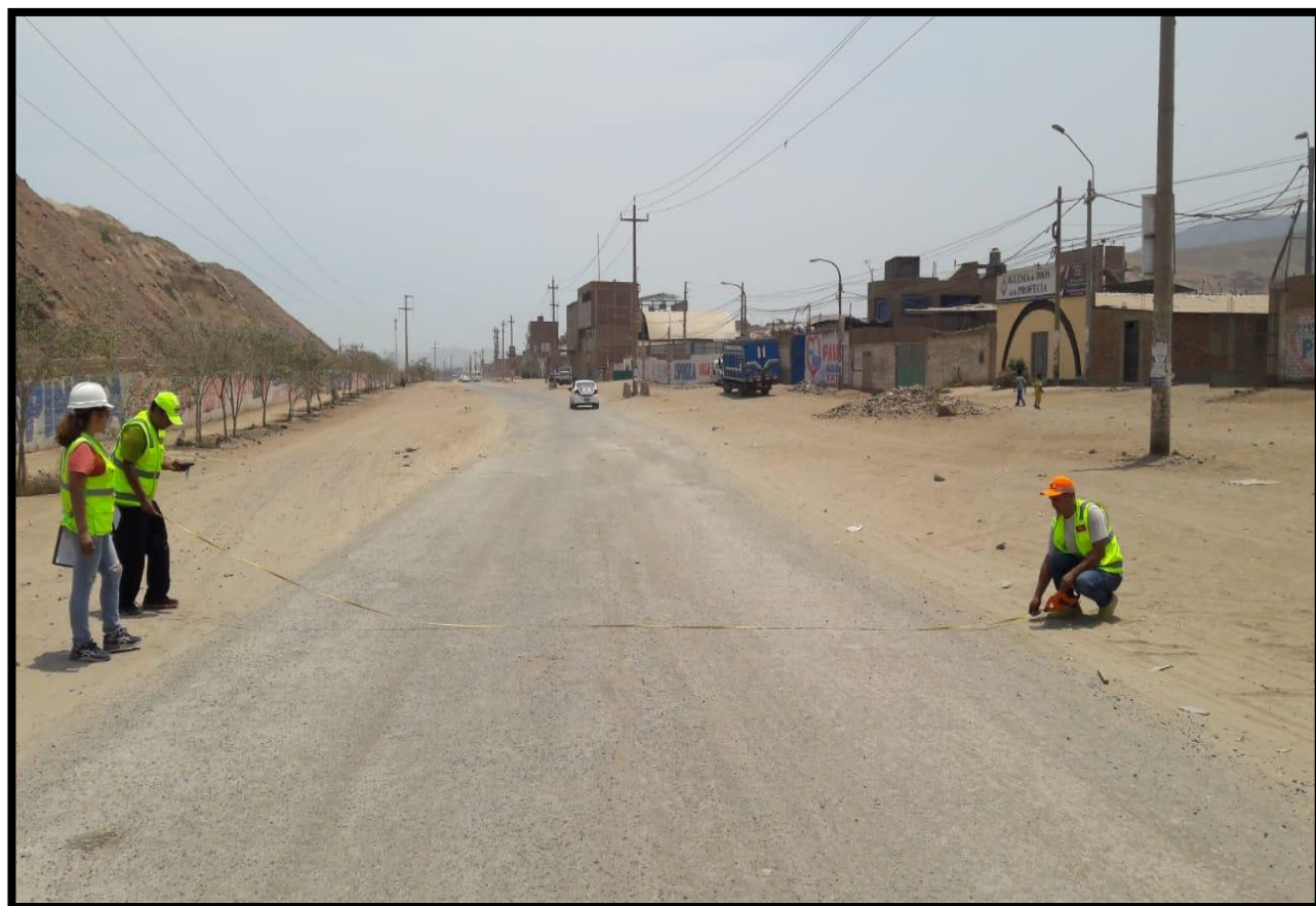
Figura 14: Foto 01- Medición de la calzada.
