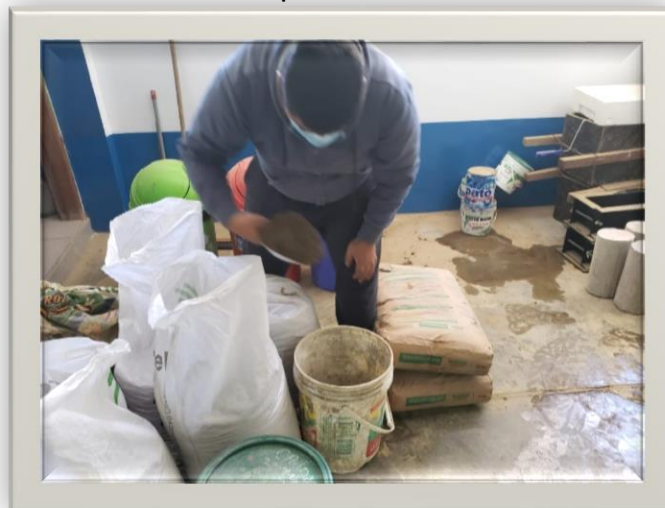
Foto 19: Preparado de los materiales para realizar la mezcla de concreto
