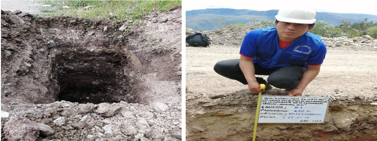
Figura 17. Proceso de apertura de las calicatas
