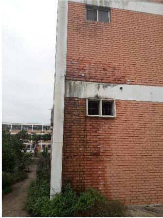
Filtraciones causadas por tuberías en mal estado.
