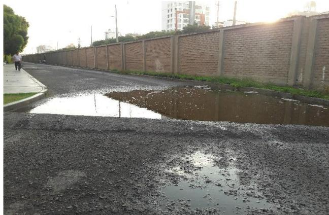
Deterioro de pavimento por lluvias
