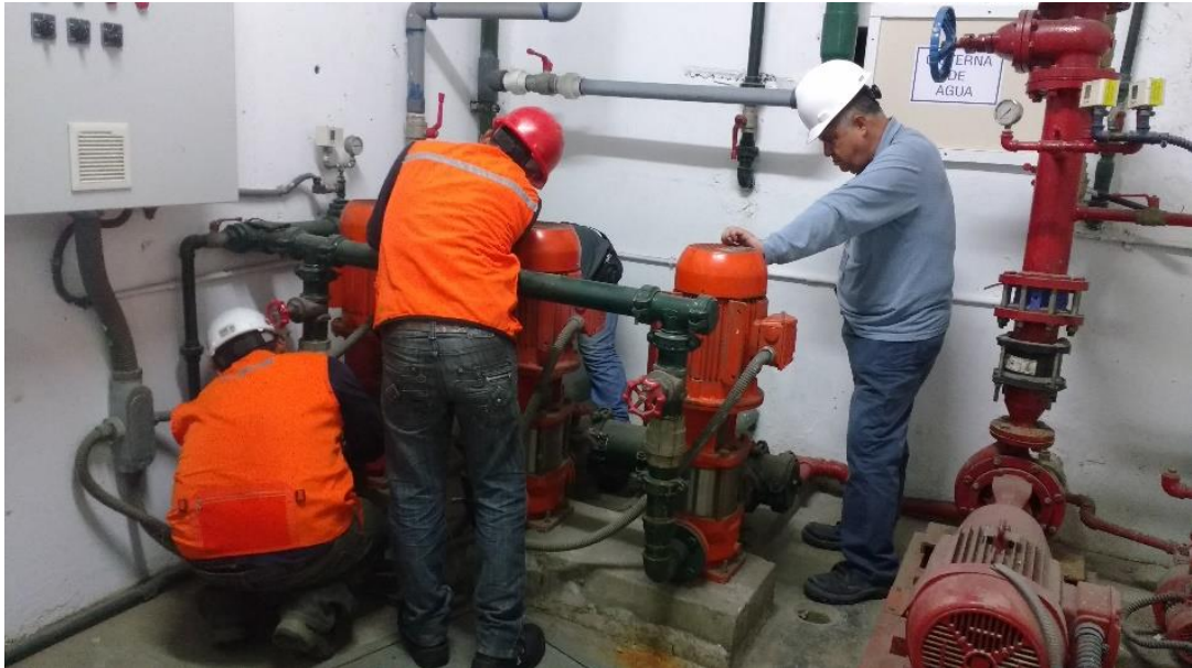
Figura 11. Inspección y control de los equipos
