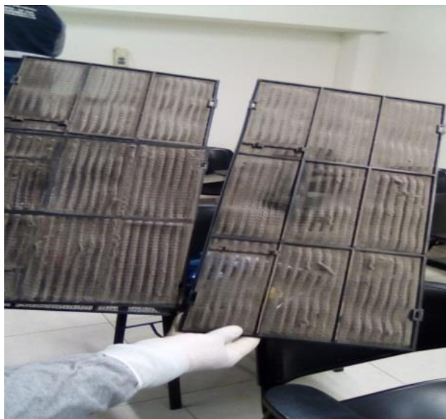
Figura 9. Limpieza de equipos
