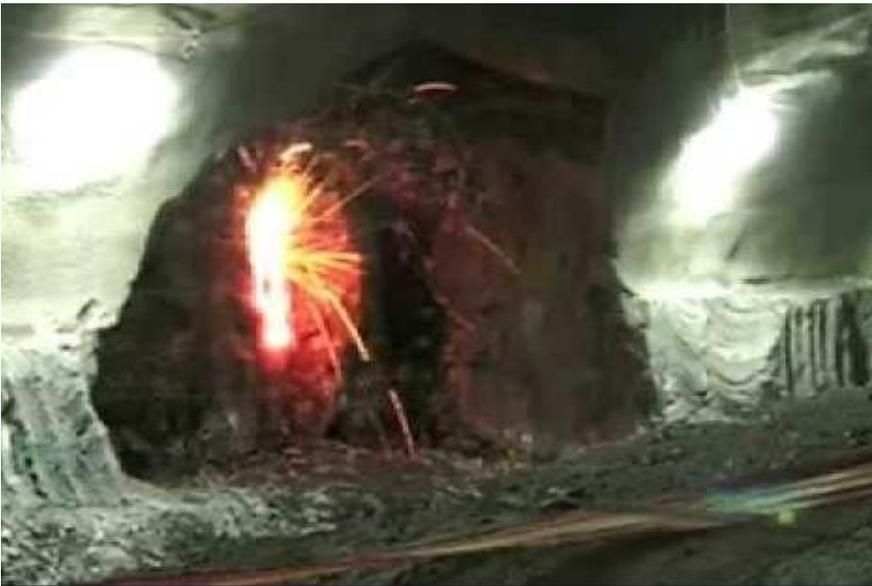
Figura 3: Rotura de la roca con material explosivo.
