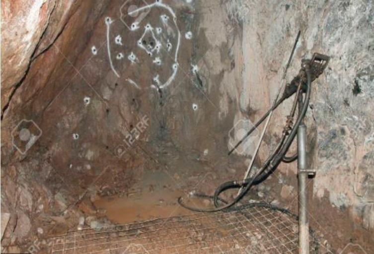
Figura 2: Puntos de señalización para la perforación de la roca.
