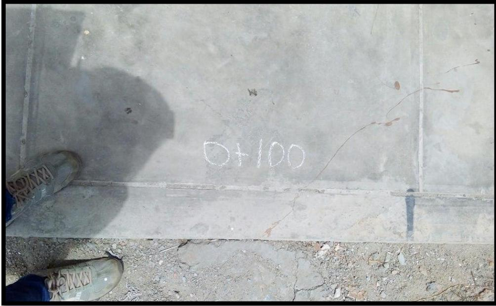
*Fotografía N° 3. Designación de cada tramo por progresivas (PR).*
