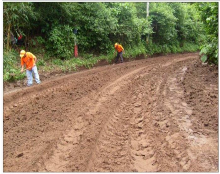
Figura 8: Limpieza de impurezas del suelo natural.
