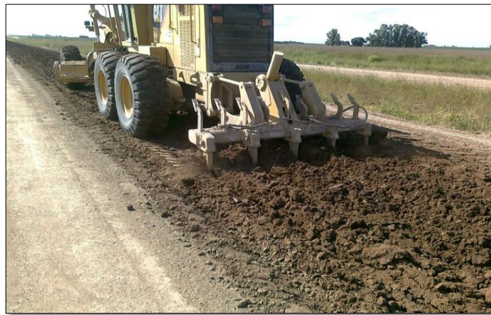
Figura 6: Escarificado del suelo natural.
