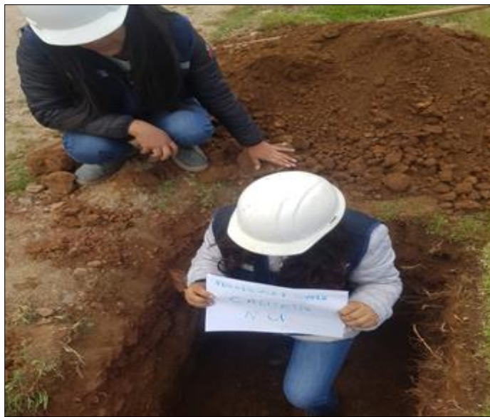
Figura 34: Identificación de calicata en acceso del distrito de santa Ana de tusi, Pasco
