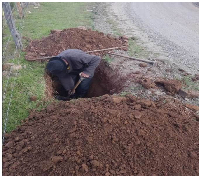
Figura 30: Excavación de calicata en acceso del distrito de santa Ana de tusi, Pasco.
