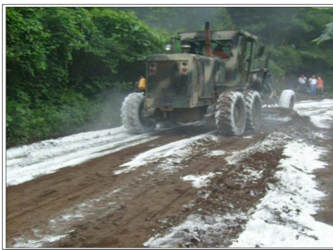
Figura 2: Mezcla de cal con el suelo natural.
