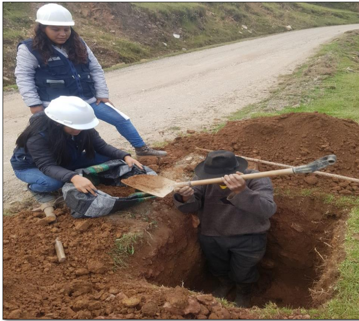
Figura 33: Excavación de calicata en acceso del distrito de santa Ana de tusi, Pasco.
