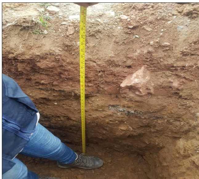
Figura 32: Excavación de calicata en acceso del distrito de santa Ana de tusi, Pasco.
