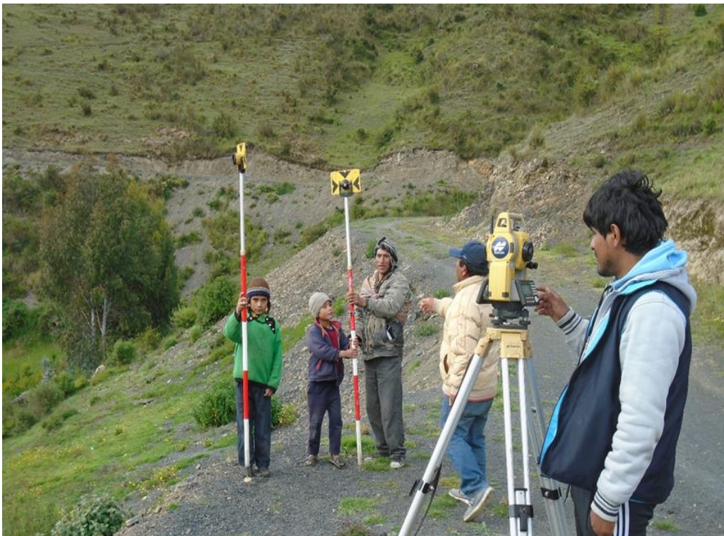
Figura 14 Levantamiento topográfico de la línea de conducción existente en la comunidad de Atocchuachancca.
