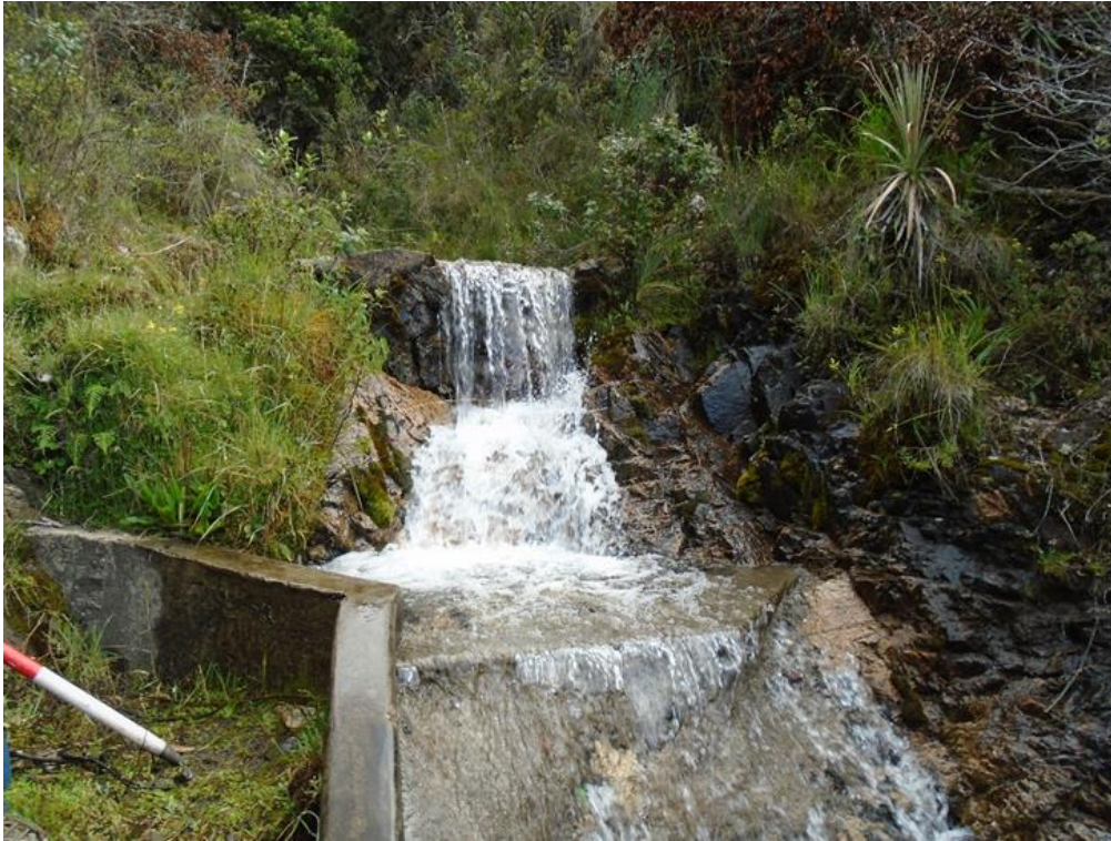
Figura 09 Vista de la captación existente Ayaorcco
