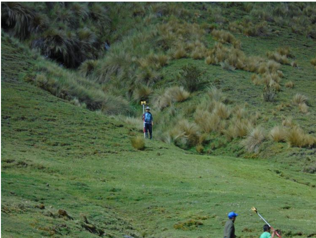
Figura 12 Levantamiento topográfico de la captación nueva a proyectar de la comunidad de Qatunpucro
