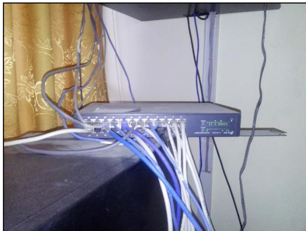
Ilustración 7 Switch de la unidad de estadística e informática del hospital Chulucanas
