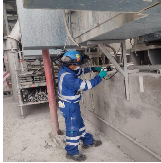
Lubricación ME lado libre con 3.2gr de grasa con contador
