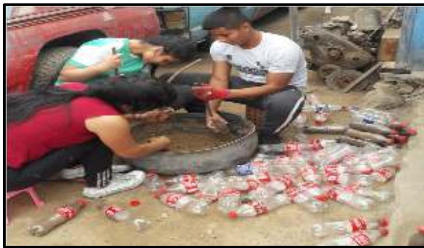
Figura N° 14: Llenado y compactacion de botellas.
