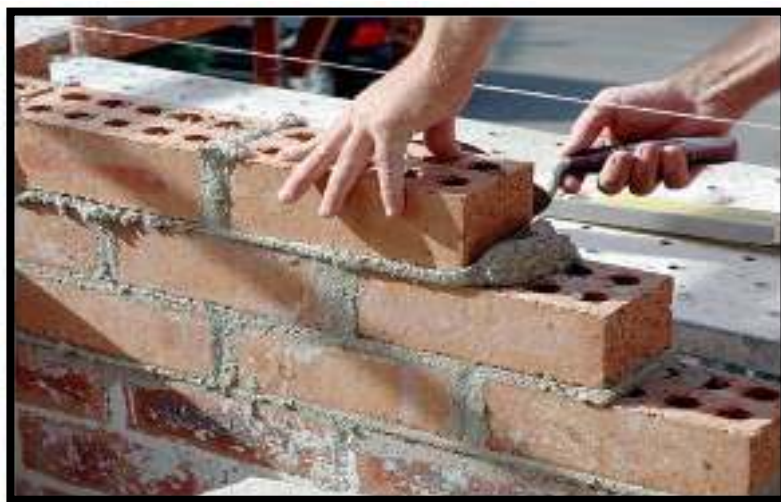
Figura N° 5: Elaboración de muros de mampostería de ladrillo.
