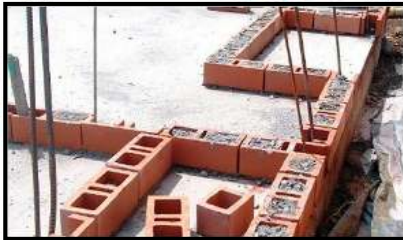
Figura N° 4: Elaboración de mampostería reforzado.
