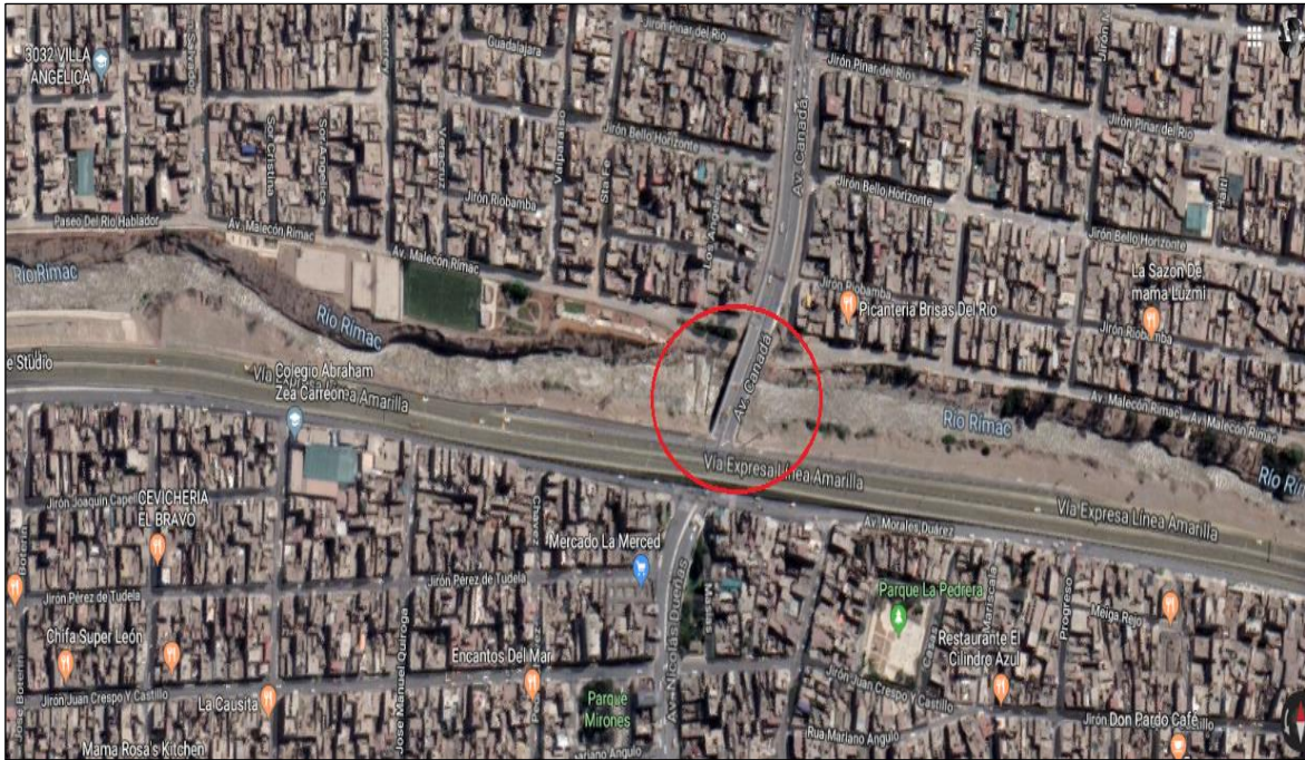
Figura 2. Ubicación del puente Nicolas Dueñas ubicado sobre el río Rímac
