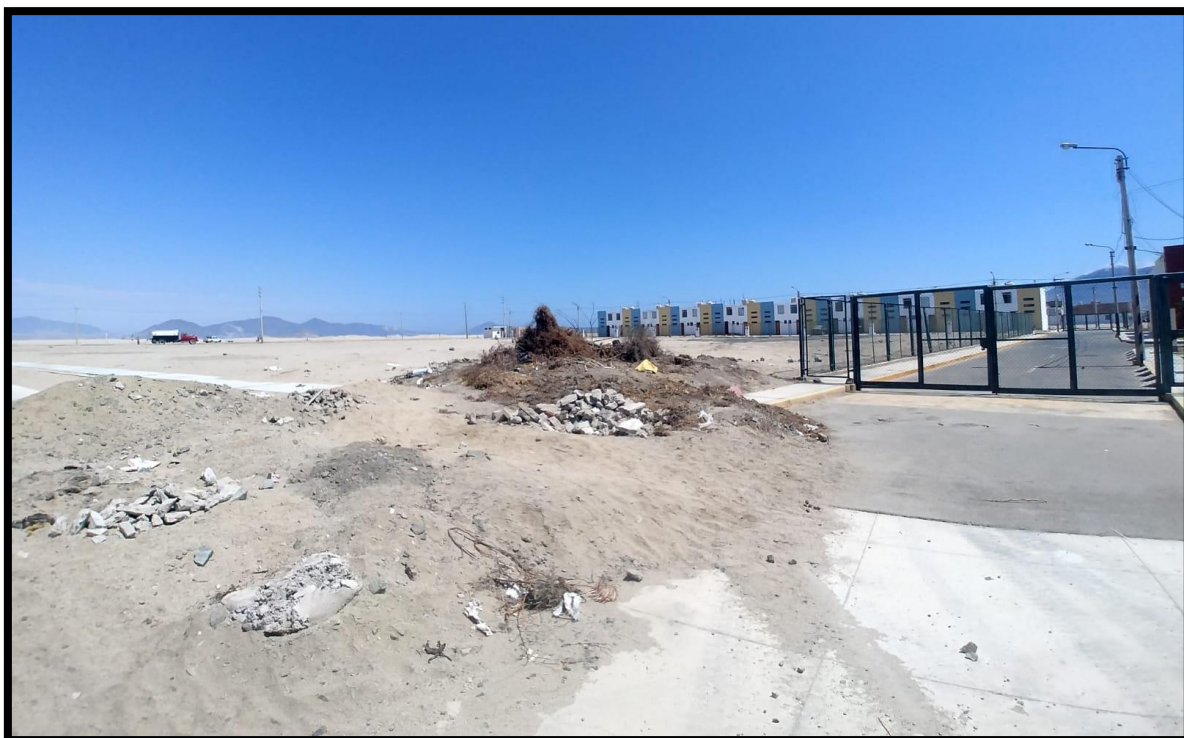
PC2: PRESENCIA DE RESIDUOS DE CONSTRUCCION EN ESTE PUNTO CRITICO SE ESTA EMPEZANDO A ACUMULAR DESMONTES, PROVENIENTE PRINCIPALMENTE DE TRICICLEROS
