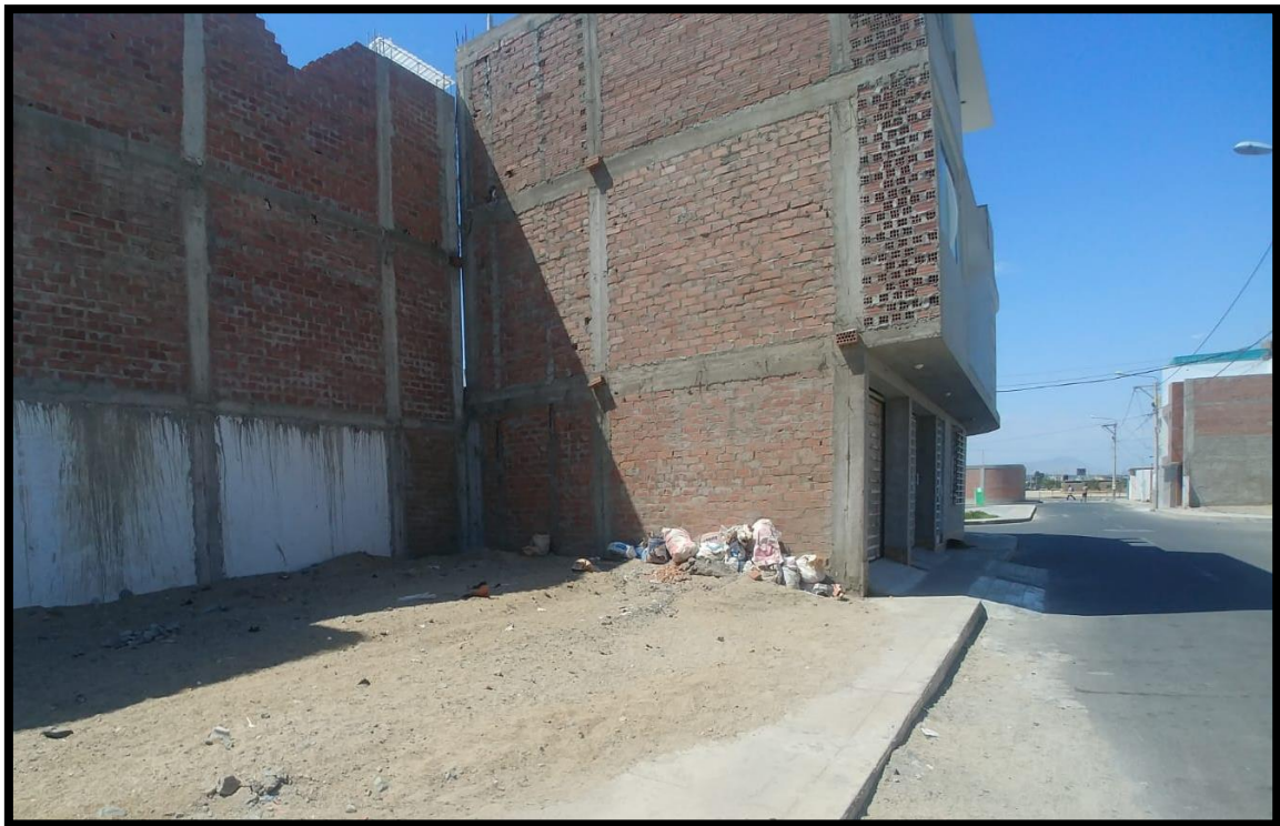
Y4: SE OBSERVA PRESENCIA DE RESIDUOS DE CONSTRUCCION ABANDONADOS
