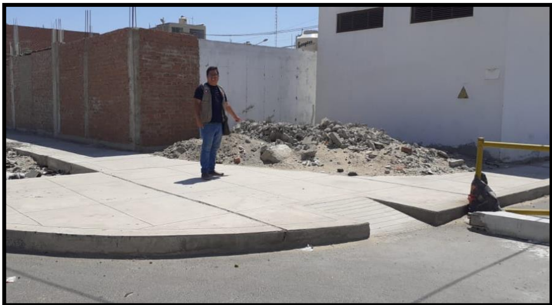
Y7: ACUMULACION DE RESIDUOS DE CONSTRUCCIÓN EN LA CALLE 33
