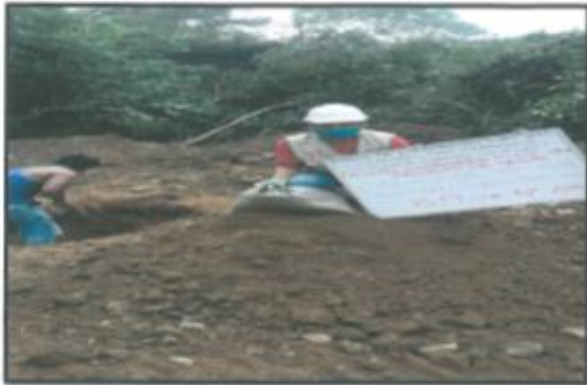
VISTA PANORAMICA A CIELO ABIERTO DE LA C - 04 - KM. 1+500
