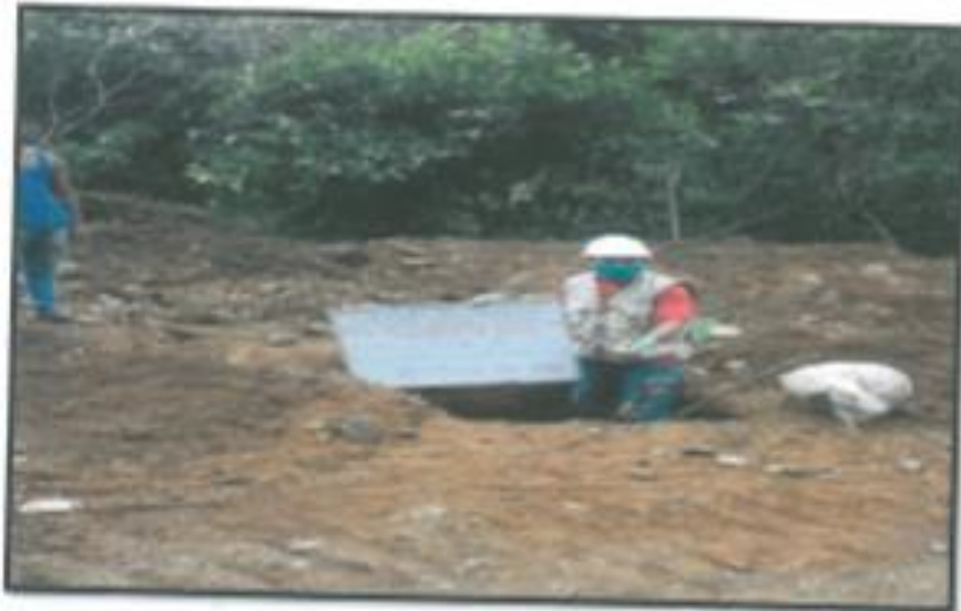
VISTA PANORAMICA A CIELO ABIERTO DE LA C - 06 - KM. 2+500
