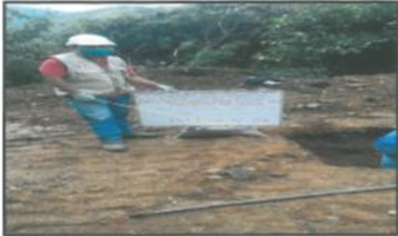
VISTA PANORAMICA A CIELO ABIERTO DE LA C - 03 - KM. 1+000
