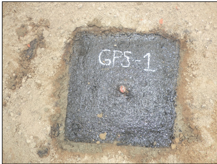
Figura 7. Monumentación de punto geodésico
