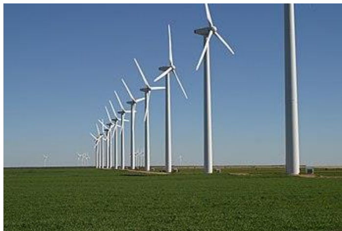
Fig. N° 10: Generación eólica, Fuente: Fuentes de generación eléctrica.
