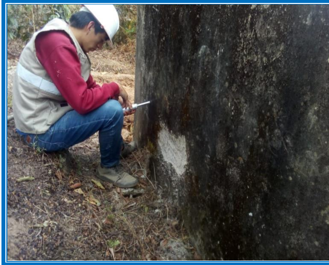
Foto N° 06. Aplicando el esclerómetro en el muro del reservorio
