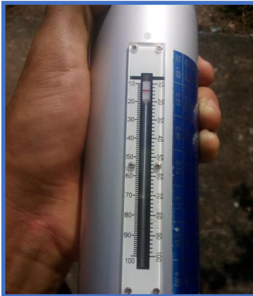
Foto N° 09. Resultado obtenido en el muro del reservorio, Muestra N°1
