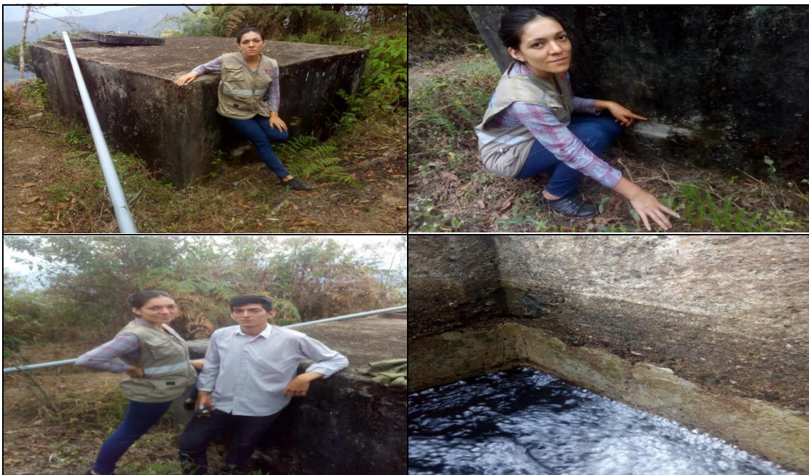
Figura 18: Estado actual del reservorio
