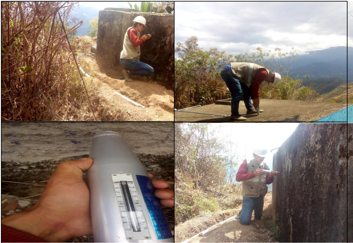
Figura 19: Ensayo de esclerometría reservorio
