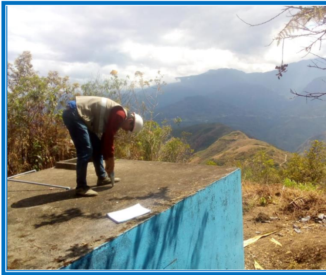
Foto N° 08. Aplicando el esclerómetro en el techo del reservorio
