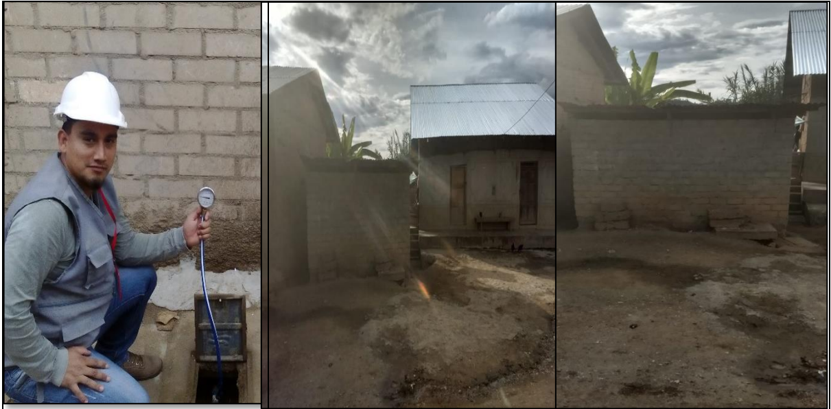
Figura 28: Toma de medición de Presión mediante manómetro, del sistema existente.
