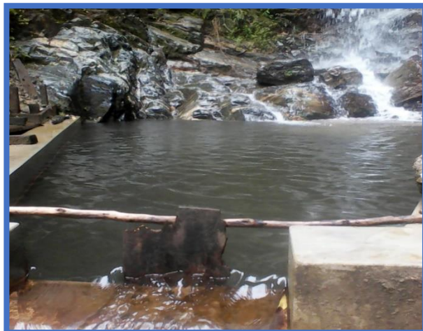
Foto N° 01. Vista de la Captación
