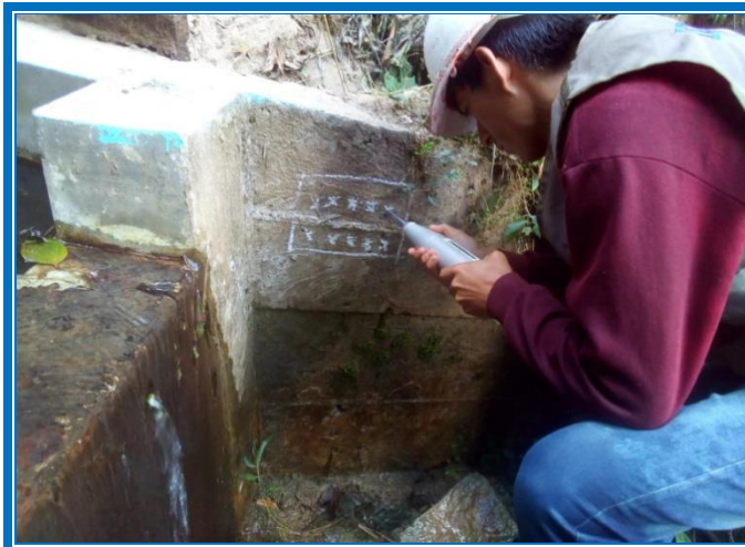
Foto N° 03. Aplicando el esclerómetro en el muro de la captación
