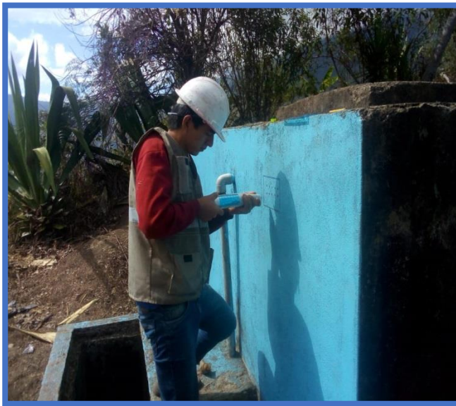
Foto N° 02. Vista del Reservorio
