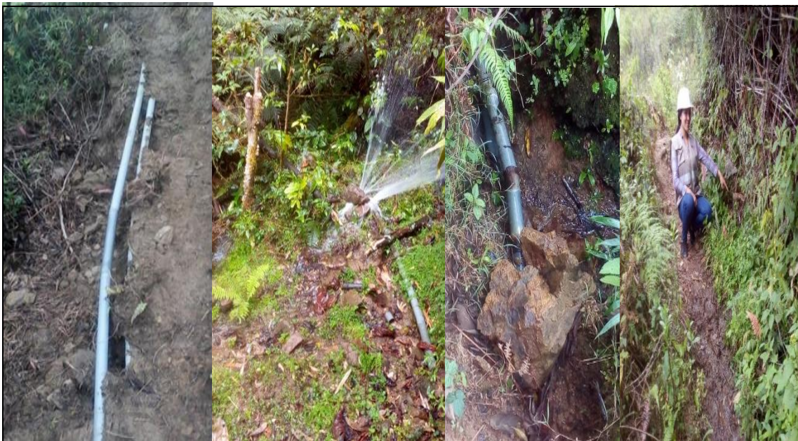
Figura 17: Estado actual de la línea de conducción
