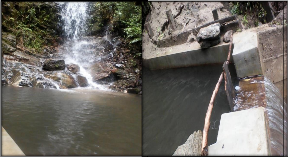
Figura 7: Captación de agua de Cruz Lomas.
