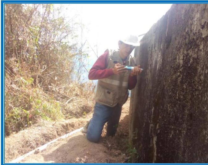
Foto N° 07. Aplicando el esclerómetro en el otro muro del reservorio
