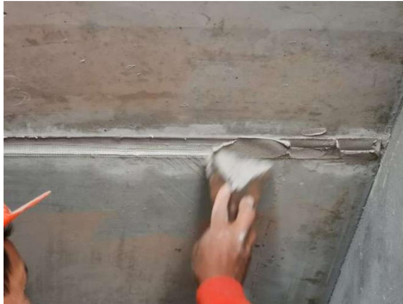
Figura N°7: “Sellado de juntas”
