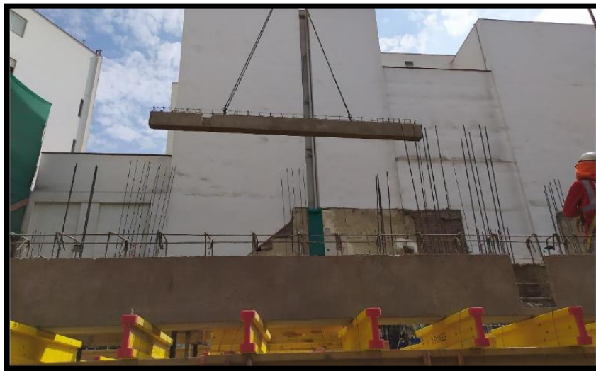
Figura N°3: “Izaje de previgas”
